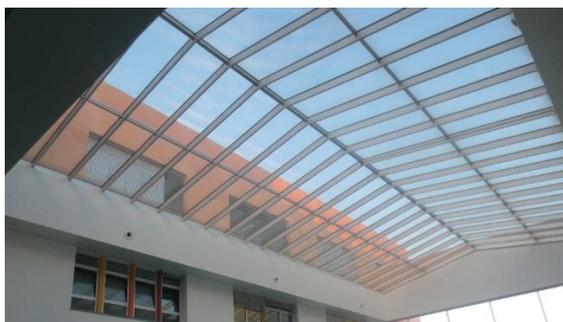
Fig. 80 – Estrutura metálica do telhado envidraçado
