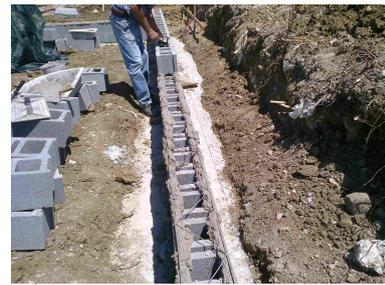
(c) Colocação da armadura pré-fabricada envolvida em argamassa
