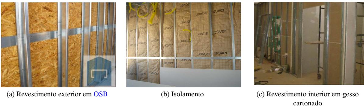
Figura 2.9: Revestimentos utilizados em LSF (Fonte, Futureng, 2013)
