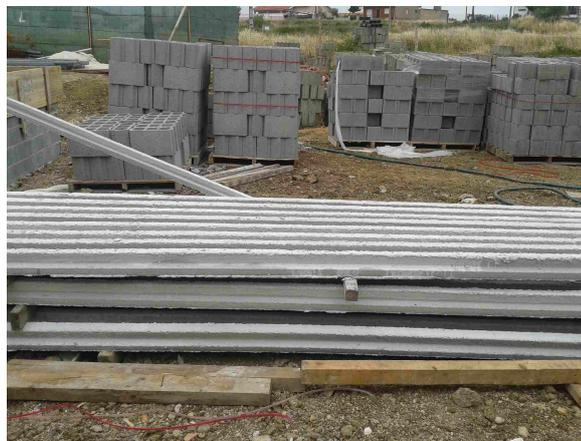
Figura 2.17: Empilhamento de vigas pré-fabricadas
