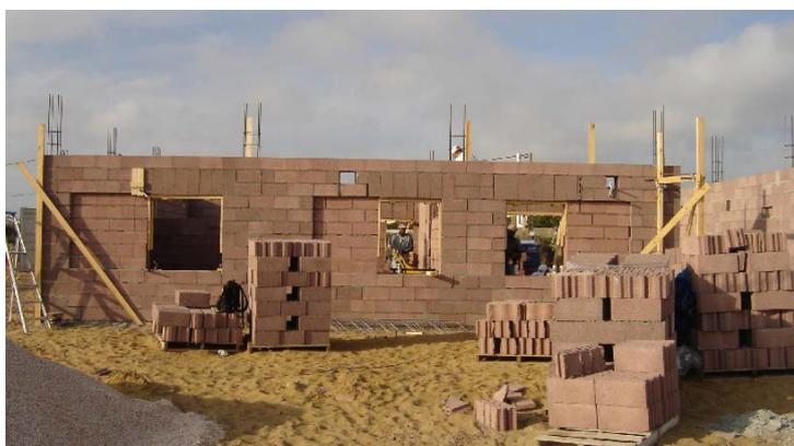
Figura 2.5: Exemplo de edifício em alvenaria confinada (Isolbloco) construído no Algarve (Gouveia *et al.*, 2006)
