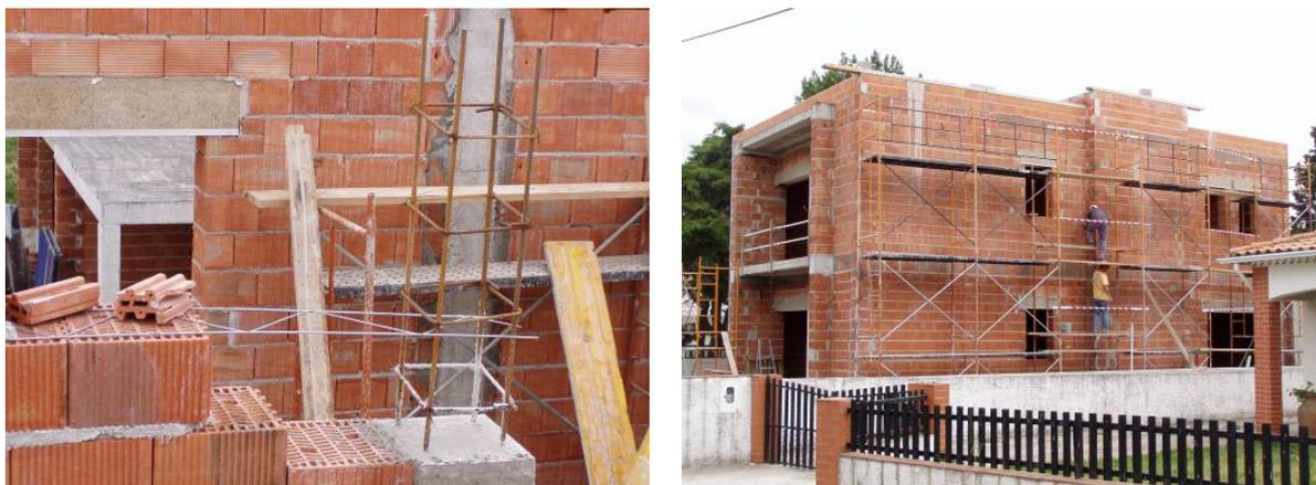
Figura 2.4: Exemplo de moradia em Ílhavo construída em alvenaria confinada (Lourenço, 2007)
