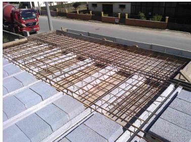
(d) Distribuição da armadura da varanda com amarração na laje
