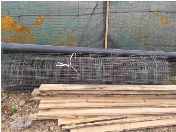
(a) Rolo de armadura de distribuição “malha-sol”
