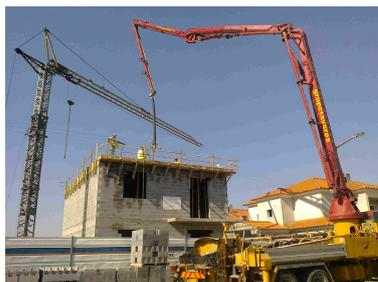
(g) Betonagem de laje com recurso a equipamento de bombagem
