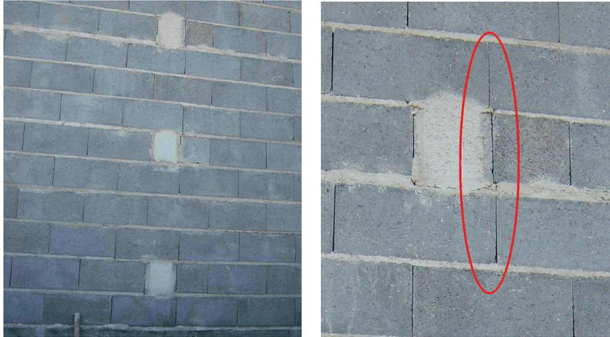
Figura 3.55: Fotografia representativa do travamento da parede contraventada (caso de estudo)
