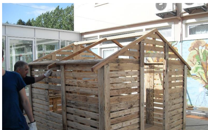
Figura 41- Construção da casa quase concluída.
