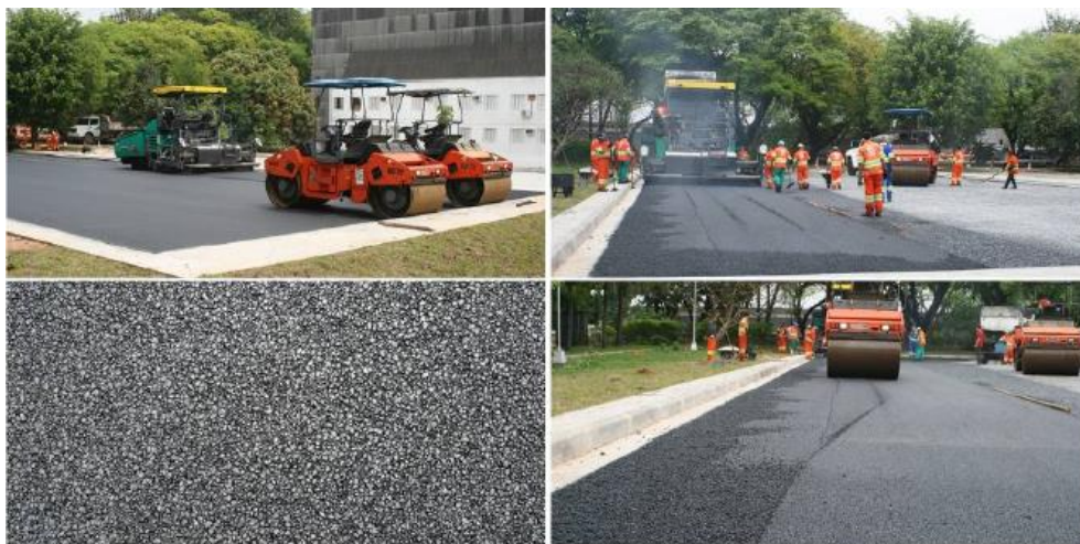
Figura IV. 12 Fase 12 Construção de Pavimento Permeável (Virgiliis, 2009)
