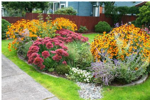
Figura 4.57 Sistema de biorretenção inserido em espaço verde (Indianapolis, s.d.)
