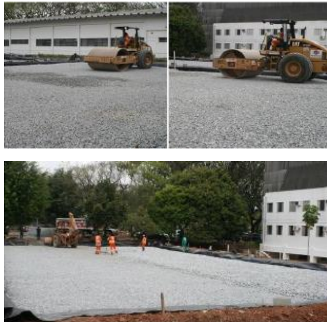
Figura IV. 7 Fase 7 Construção de Pavimento Permeável (Virgiliis, 2009)
