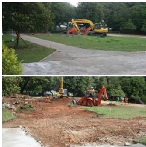
Figura IV. 1 Fase 1 Construção de Pavimento Permeável (Virgiliis, 2008)
