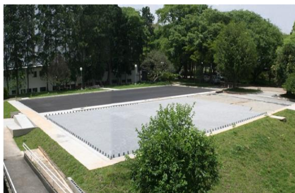
Figura IV. 15 Fase 15 Construção de Pavimento Permeável (Virgiliis, 2009)
