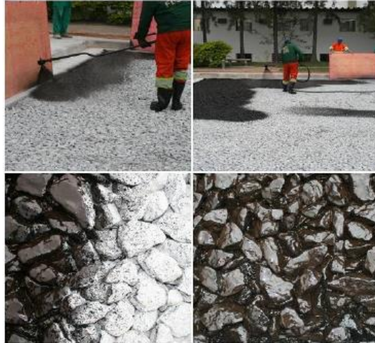
Figura IV. 11 Fase 11 Construção de Pavimento Permeável (Virgiliis, 2009)
