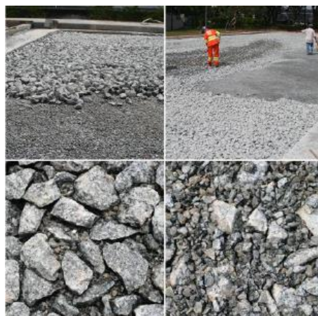
Figura IV. 10 Fase 10 Construção de Pavimento Permeável (Virgiliis, 2009)
