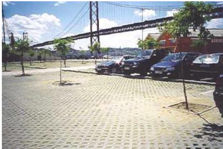
Figura 4.22 Pavimento Poroso – Parque de Estacionamento Doca de Santos, Lisboa (Adaptado de Ferreira (2000))
