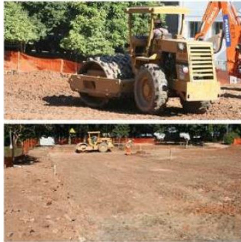
Figura IV.3 Fase 3 Construção de Pavimento Permeável (Virgiliis, 2009)
