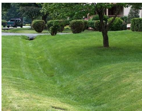
Figura 4.56 Vala relvada integrada em zona urbana (Fairfax, 2007)
