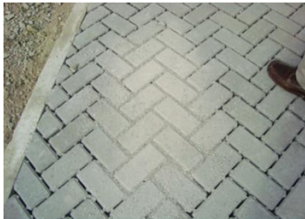
Figura IV. 14 Fase 14 Construção de Pavimento Permeável (ABCP, s.d.)
