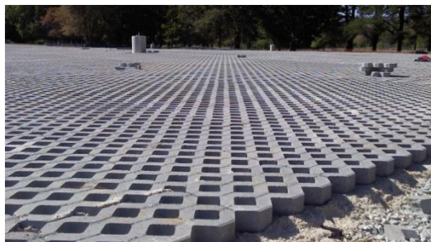
Figura 4.29 Pavimento permeável em blocos de betão alveolares (Rhino Pisos, 2014)
