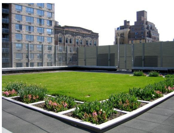
Figura 4.51 Cobertura semi-intensiva instalada numa escola em Manhattan, onde há uma separação nítida entre as zonas extensiva e intensiva (Castelo-Branco, 2012)
