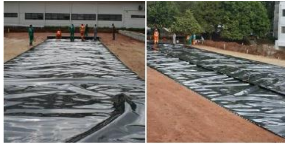
Figura IV. 5 Fase 5 Construção de Pavimento Permeável (Virgiliis, 2009)
