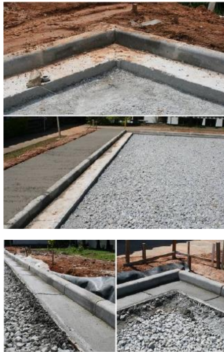
Figura IV. 9 Fase 9 Construção de Pavimento Permeável (Virgiliis, 2009)
