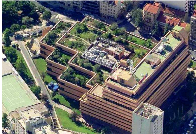
Figura 4.43 Vista aérea da cobertura verde do edifício da Portugal Telecom em Picoas (Costa, 2010)
