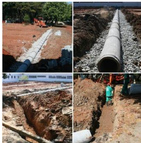
Figura IV. 4 Fase 4 Construção de Pavimento Permeável (Virgiliis, 2009)
