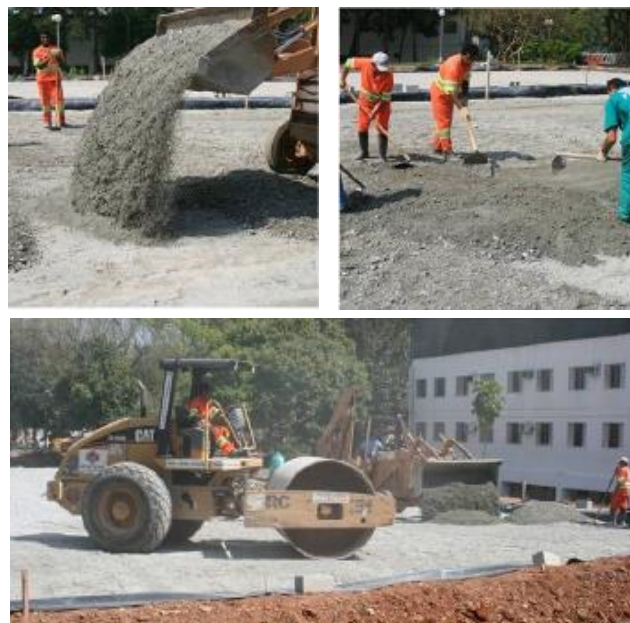
Figura IV. 8 Fase 8 Construção de Pavimento Permeável (Virgiliis, 2009)
