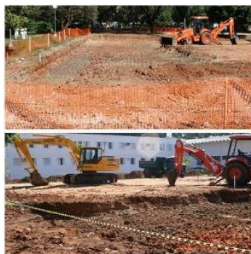
Figura IV. 2 Fase 2 Construção de Pavimento Permeável (Virgiliis, 2009)
