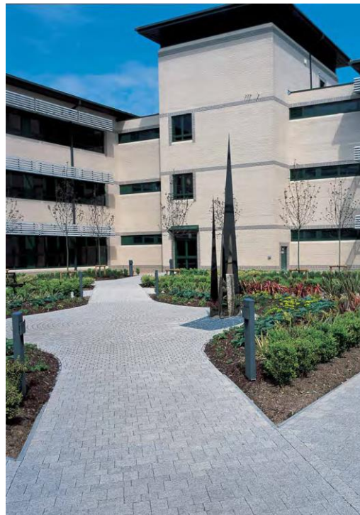
Figura 4.27 Pavimento permeável em blocos de betão (FORMPAVE, 2014)
