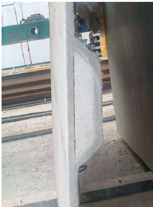
Figura 3.2 – Exemplo de nervura de um painel do tipo nervurado
