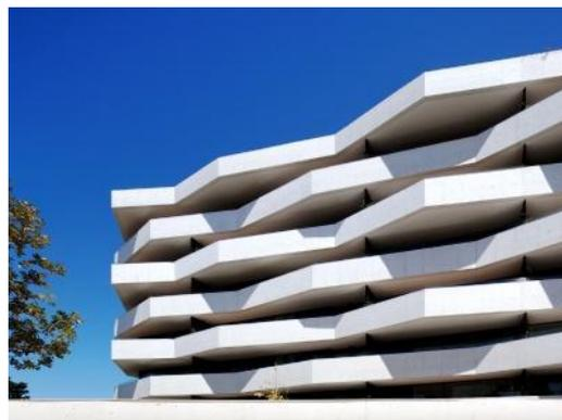
Figura 2.1 – Exemplo de aplicação em GRC a nível da engenharia
