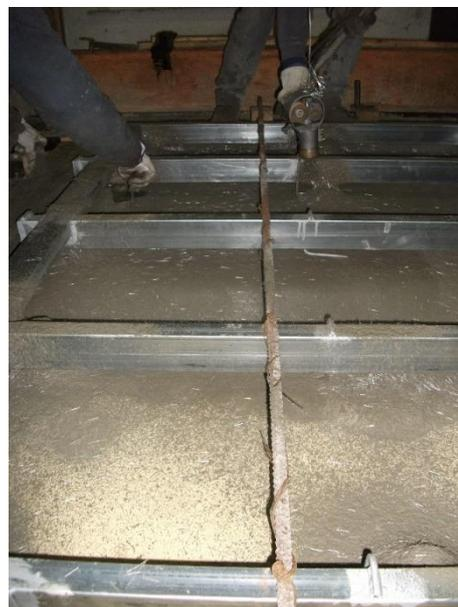
Figura 3.7 – Projeção da matriz de argamassa e da fibra de vidro em simultâneo
