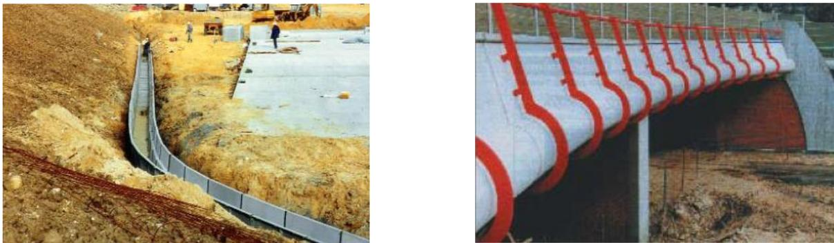
Figura 2.2 – Exemplo de aplicação em GRC a nível da engenharia
