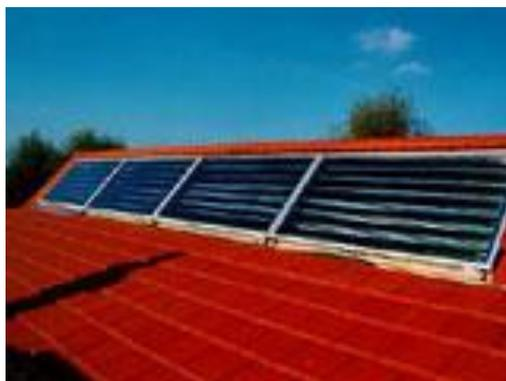
Figura 4.7. Colectores concentradores parabólicos compostos (CPC) (adaptado de [www.energiasrenovaveis.com](http://www.energiasrenovaveis.com))
