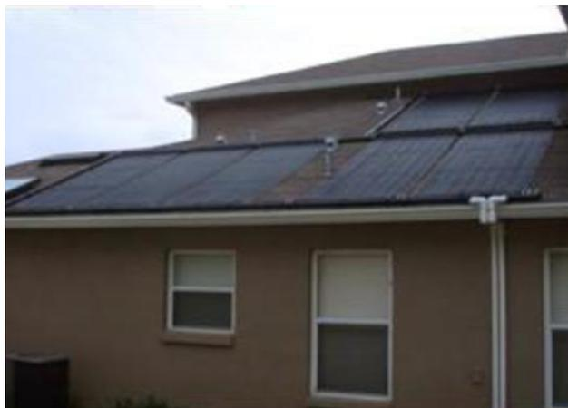
Figura 4.3. Colector solar plano sem cobertura (adaptado de Grade, A., Equipamentos Térmicos – Aulas Teóricas, 2012)
