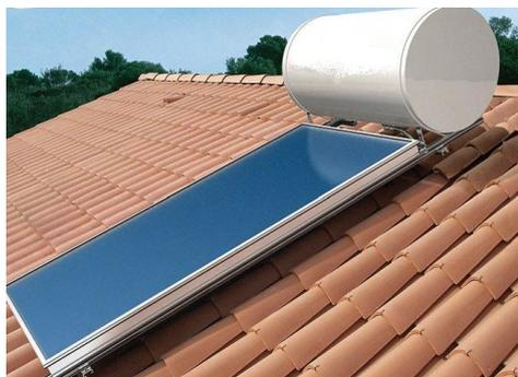
Figura 4.5. Coletor solar plano com cobertura (adaptado de osinovadores.net23.net, 2010)
