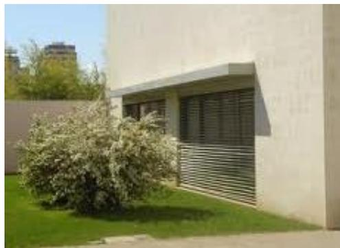
Figura 3.5. Elemento fixo de sombreamento - Pala horizontal
