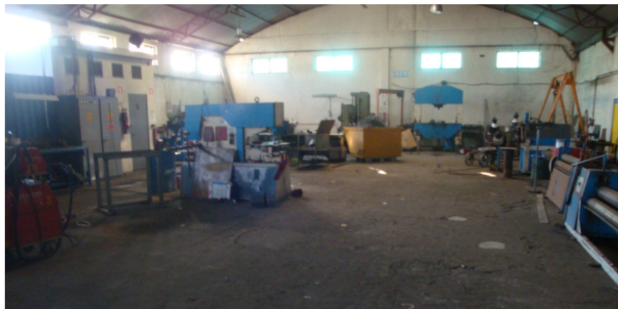
Figura 24 - Zona de Maquinação Antes da Intervenção
