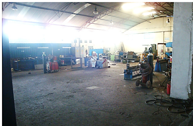
Figura 26 - Zona de Maquinação Antes da Intervenção
