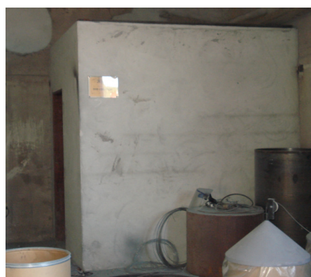
Figura 51 - Armazém de Materiais de Suporte à Atividade de Soldadura
