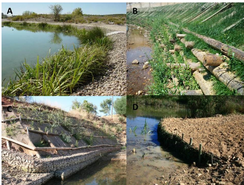
Figura 5 – Aplicação da Engenharia Natural em diversas situações. A: Aplicação de tapetes herbáceos em margens lagunares (Fonte: Freitas, 2012); B: Aplicação de muros de suporte vivo na estabilização e recuperação ecológica de taludes (Fonte: Freitas, 2012); C: Aplicação de grades vivas (gradeamentos com vegetação) em encostas íngremes (Fonte: Quinta-Nova, s.d.); D: Aplicação de entrancados vivos (sebes entrancadas) como sistema de estabilização da camada superficial do solo (Fonte: Quinta-Nova, s.d.).
