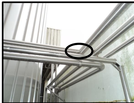
Figura 8-9 Derivação de CIP á linha dos Coletores.
