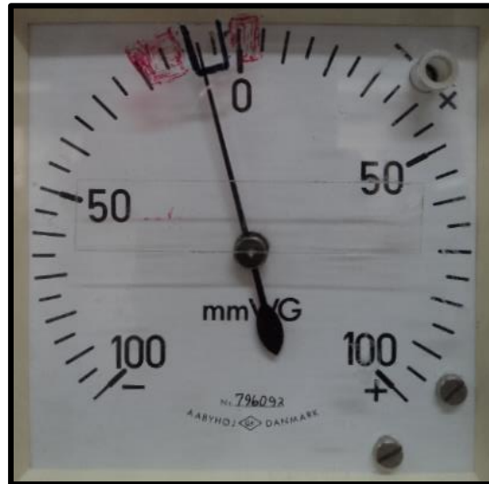
Figura 8-19 Manómetro de leitura analógico de pressão na camara.
