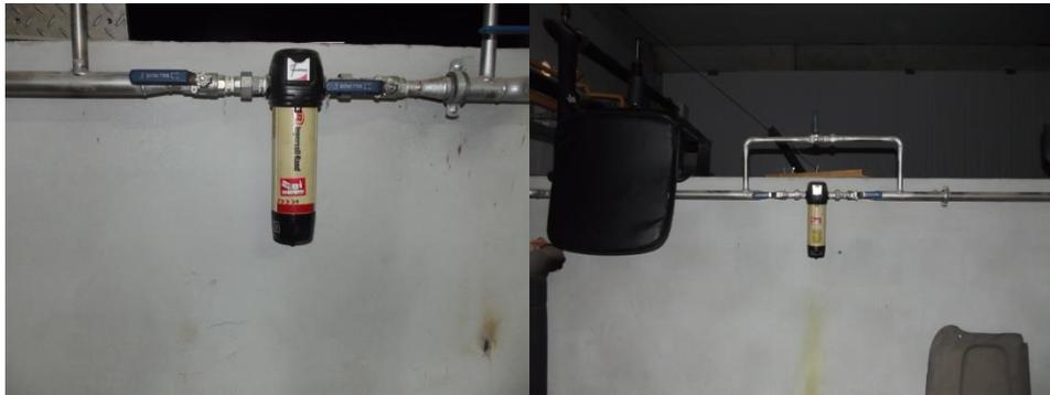
**Figura 36: Filtros de retenção de humidade**
