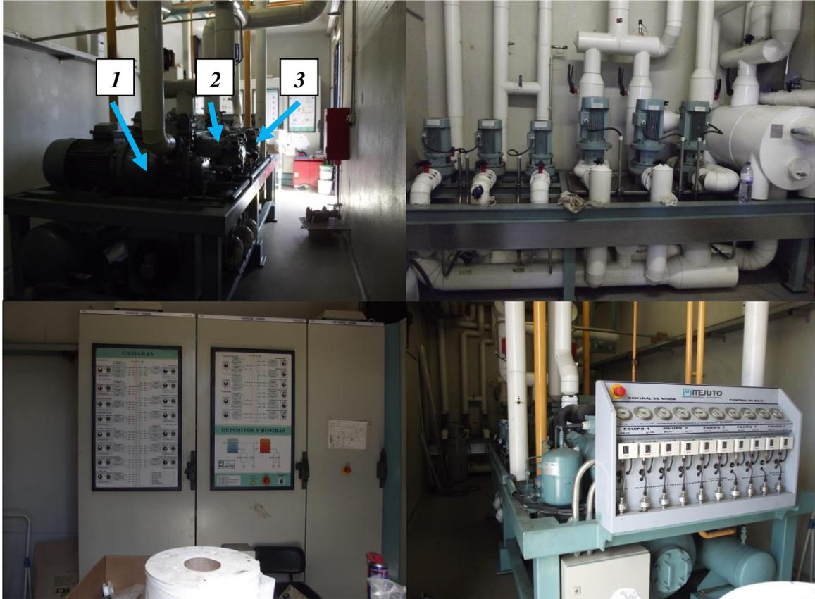
**Figura 38: Compressores da Unidade de Frio**
