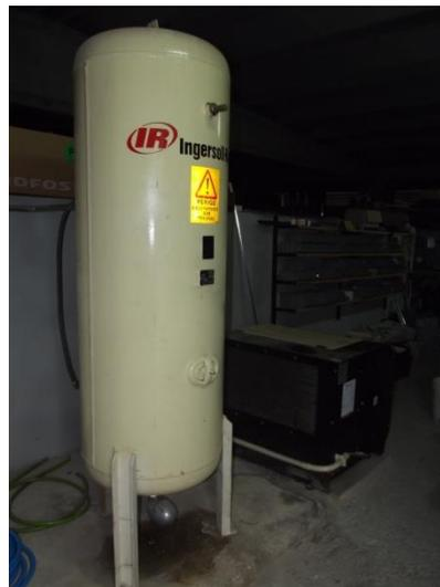
Figura 34: Deposito acumulador de ar comprimido
