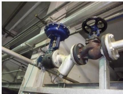
**Figura 27: Válvula de vapor do escaldão da unidade fabril**
