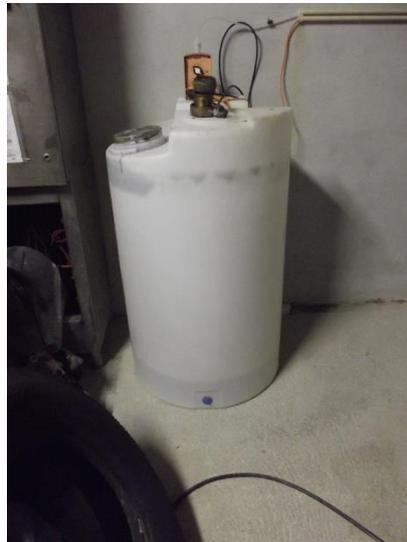
**Figura 19: Doseador de cloro para reservatório de água**
