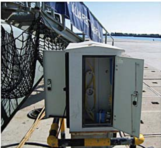
Pormenor de um PAC da BNL onde se podem ver os 2 compartimentos: um onde o navio liga o umbilical e o outro a área técnica.
