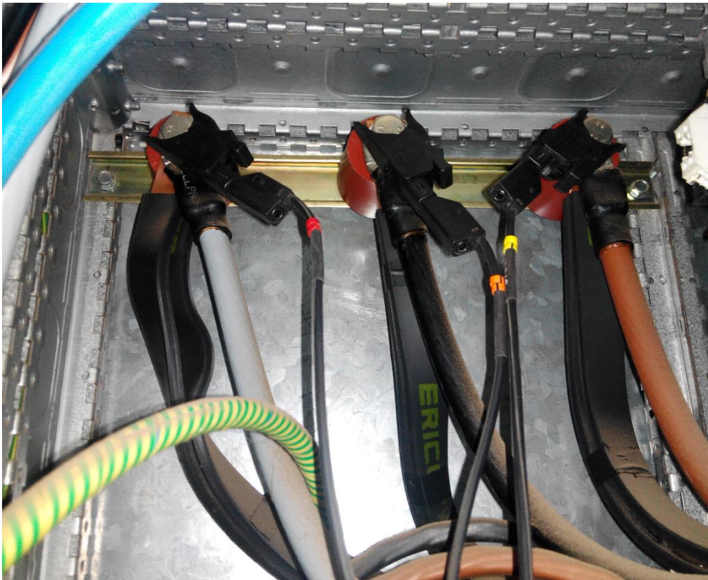
Figura 6.7. Analisador ligado ao quadro
