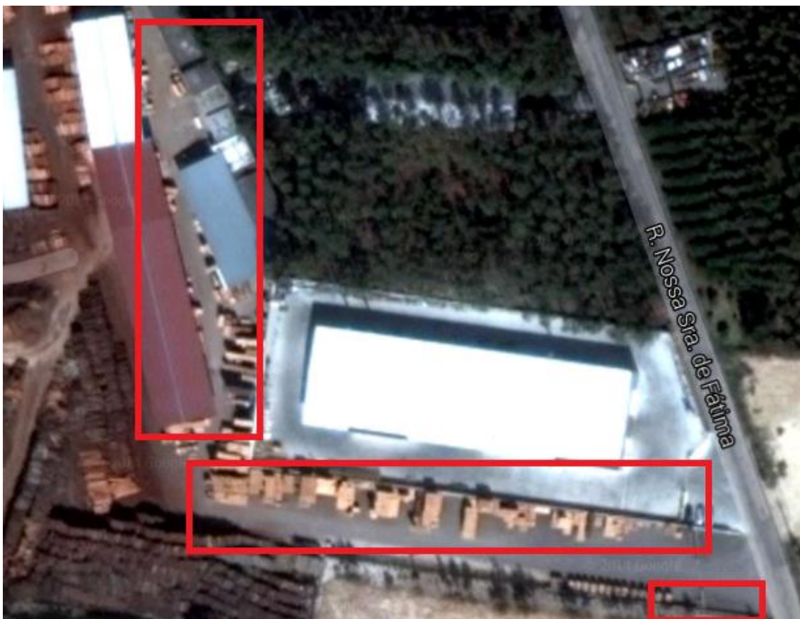
Figura 5.12. Parque de armazenamento das paletes [6]
