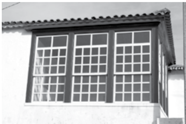
Fig 2. Pedrógão Pequeno: situação actual de um exemplo de varanda envidraçada registado pela equipa das Beiras. 2010 (© Nuno Pinto Cardoso)
