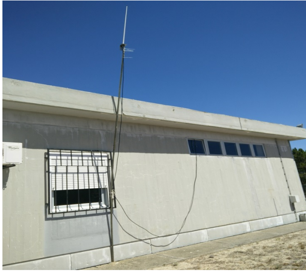
Figura 4.19: Montagem da Antena CX4
