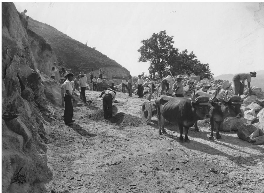
Figura 1. Construção dos acessos para a Central de Venda, Casa Alvão, 1947. Arquivo EDP, Porto.
