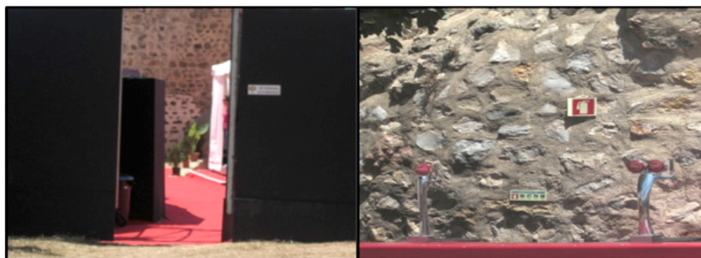
Figura 26 - Sinalética que interdita a passagem para o backstage e placa fotoluminescentes que indica a existência de um extintor
