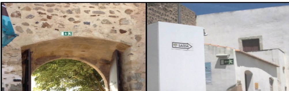
Figura 24 - Saídas de emergência - placas fotoluminescente
