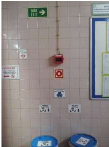
Figura 6 - Botoneira Manual de Alarme
