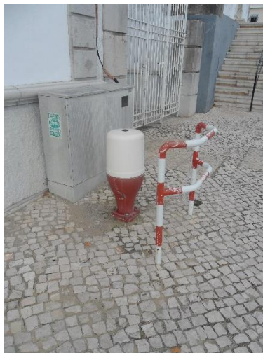
Figura 5- Marco de incêndio
