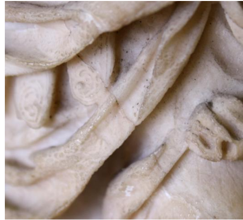
Fig. 29– Fissura na zona central da figura “Atena”.
