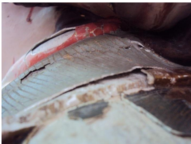
Fig.164 Destacamento de policromia
