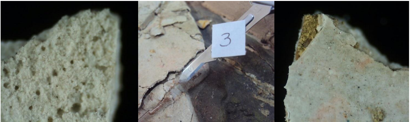
Fig.71 Vista da preparação
