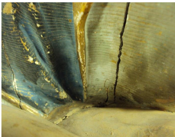
Fig.157 Abertura das juntas de ligação de blocos
