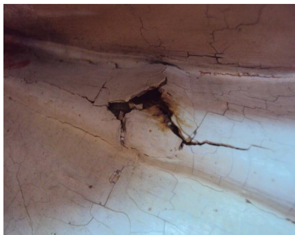
Fig.158 Elemento metálico oxidado no sudário
