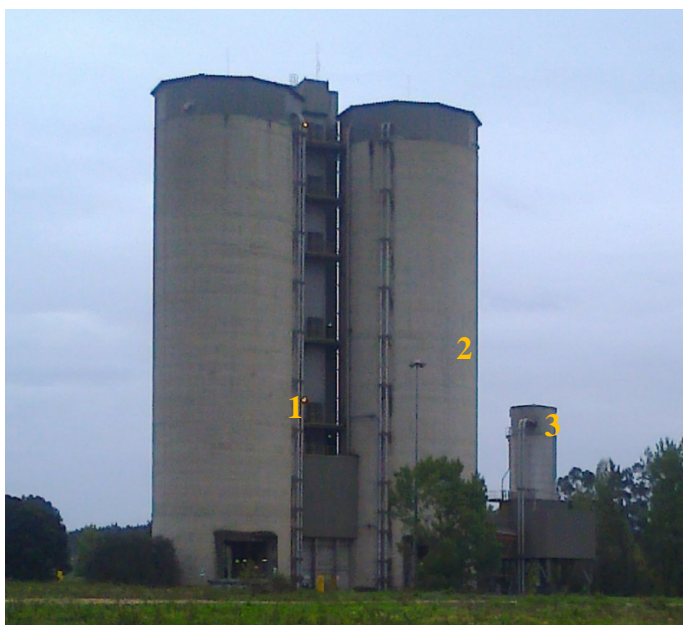
Figura 4.1 – Silos de armazenagem e descarga das cinzas (1) – Silo Principal 20; (2) Silo Principal 10; (3) Silo de Arranque 01. Fotografia tirada a 23-10-2013
