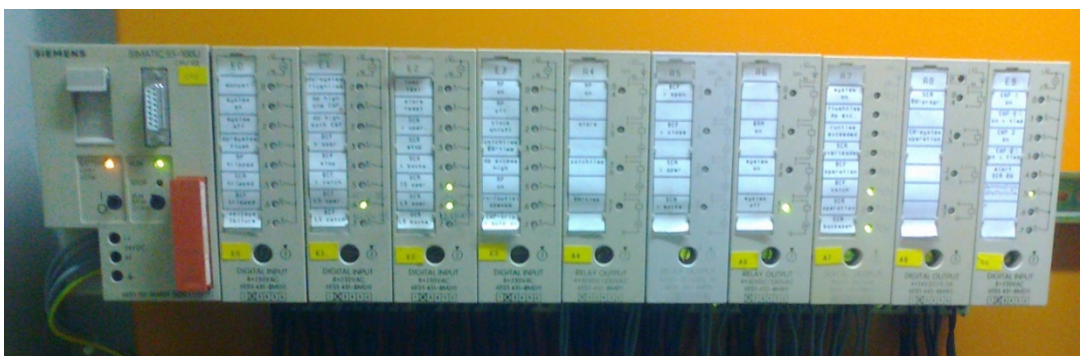
Figura 3.34 – Módulos do Autómato S5-100U do sistema actual
