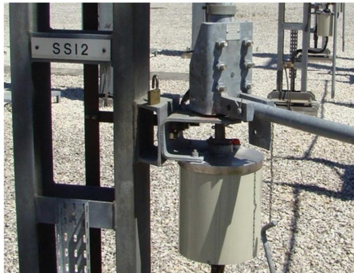
**Figura 2-45 Encravamento mecânico Tipo C**
