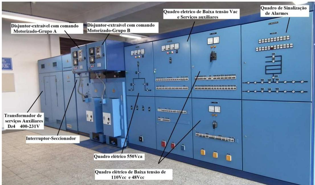
**Figura 2-52** Quadro elétrico de média tensão e serviços auxiliares da SST de Carcavelos
