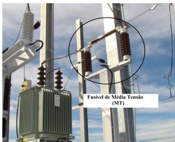
**Figura 2-83 Fusível de Média tensão de proteção do transformador**
