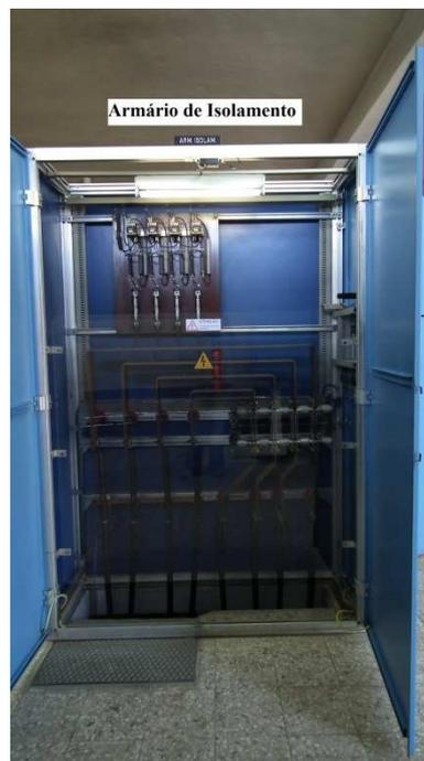
Figura 2-54 Armário de isolamento da SST de Cascais
