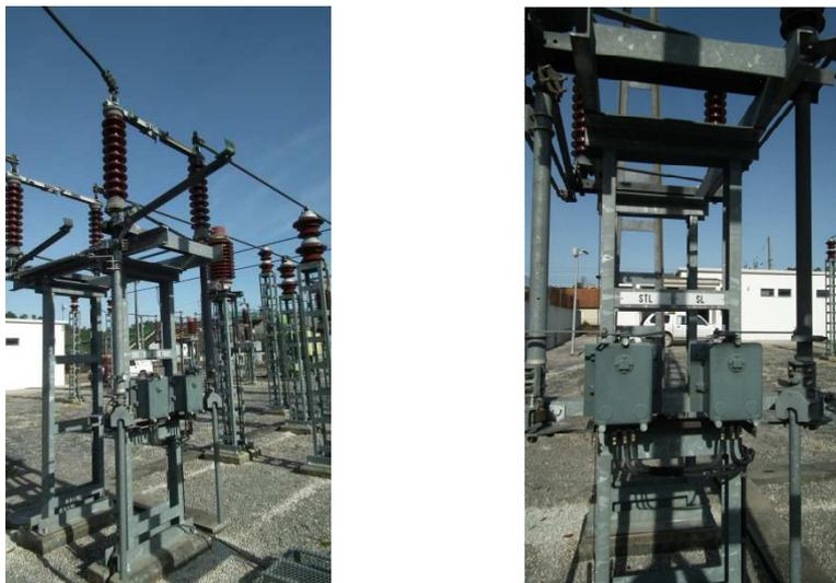
Figura 2-43 Encravamento mecânico Tipo A- Seccionador de terra e de linha à ( esquerda), pormenor do encravamento mecânico do seccionador de terra e de linha (direita)
