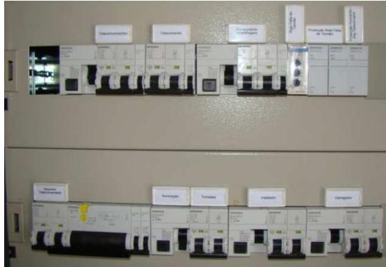
**Figura 2-77** Quadro de entrada da alimentação elétrica de posto de catenária
