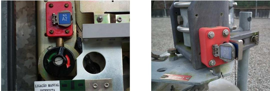
**Figura 2-44 Encravamento mecânico Tipo B- Após a abertura do disjuntor (esquerda), é libertada a chave SL2 A2, manobrar o seccionador (direita)**
