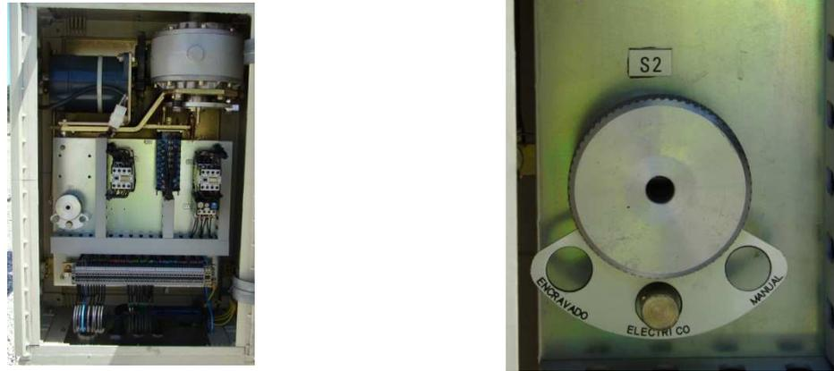
**Figura 2-46** Caixa de comando com encravamento mecânico Tipo D (esquerda), pormenor do encravamento (direita)
