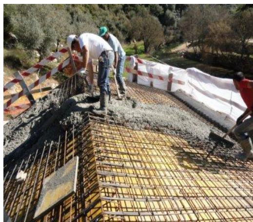
Figuras 57 – Início da betonagem da laje.
