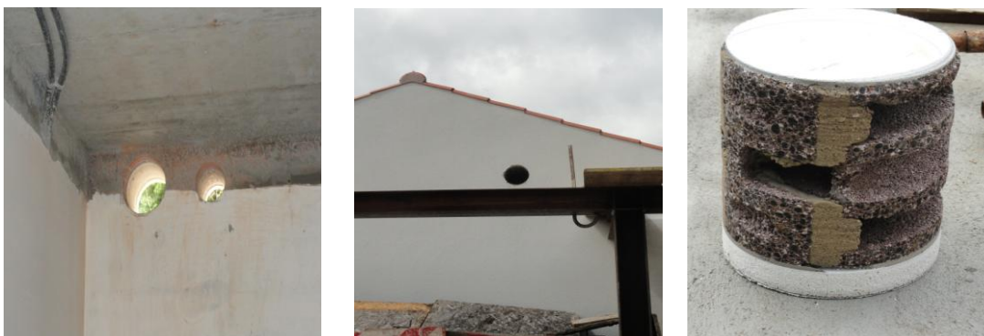
Figuras 79 – Furação da parede, para garantir renovação de ar e respetiva carote.
