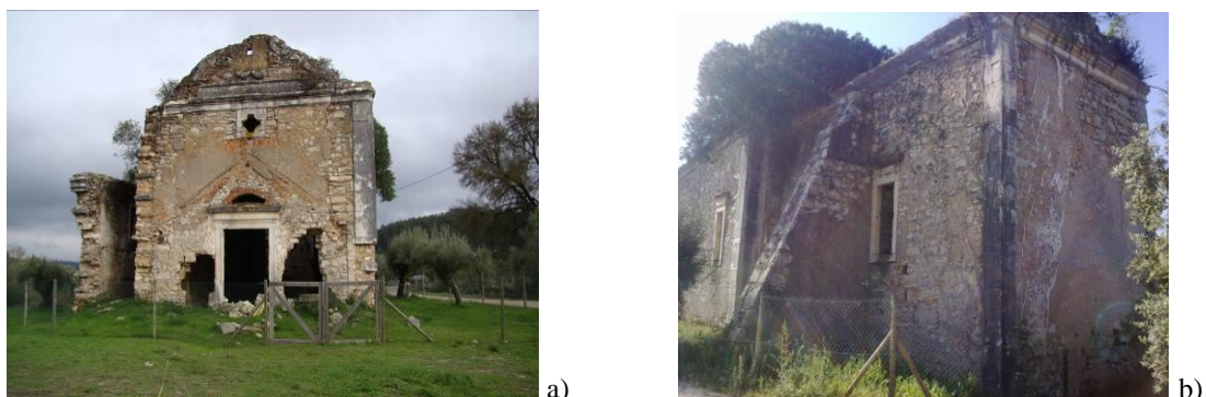
Figuras 4 – Vistas da Capela: a) Fachada principal; b) Capela-mor com contraforte.
