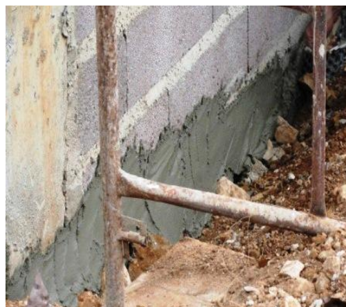
Figuras 67 – Preparação par receber sistema de isolamento “tipo Capoto”.
