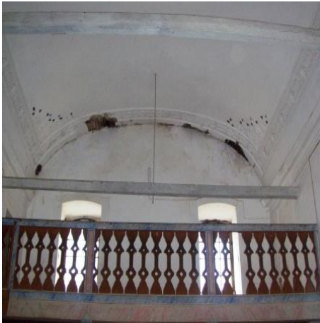
Figuras 117 – Reparação da abóbada da nave com estuque (antes da intervenção e detalhe durante a intervenção).
