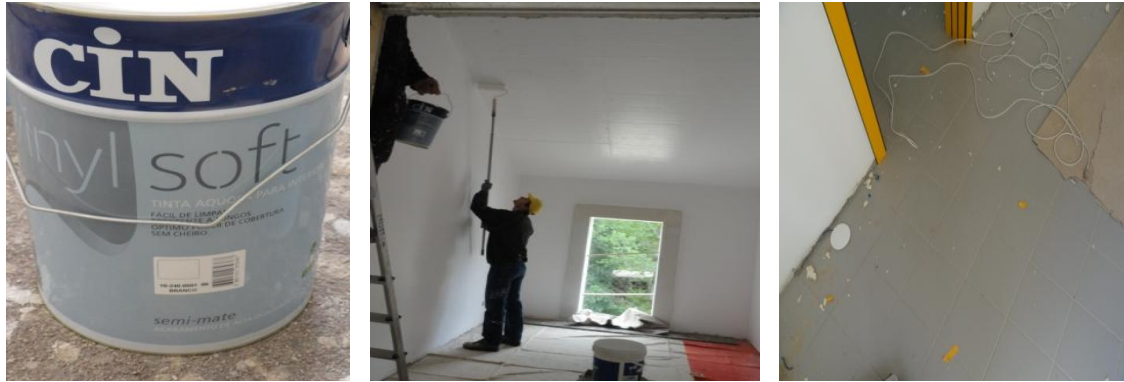
Figuras 82 – Pintura das paredes interiores com tinta aquosa semi-mate.
