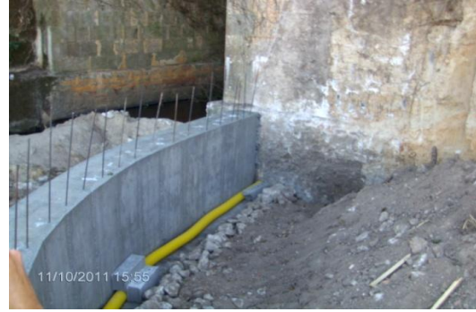
Figura 131 – Muro ala descofrado e colocação de tubo de dreno.
