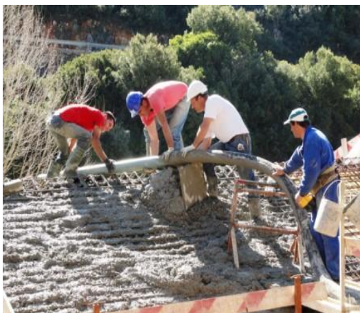
Figuras 58 – Betonagem da laje.
