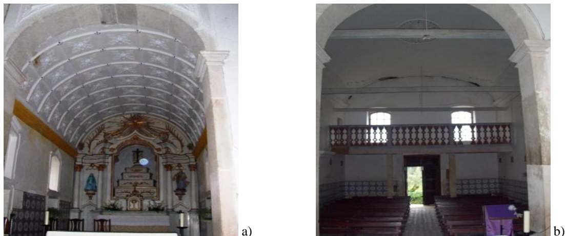
Figura 92 – a) Capela-mor; b) Nave principal.
