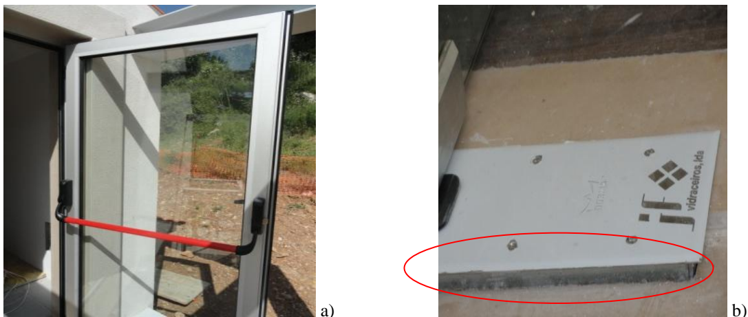
Figuras 88 – a) Porta exterior de alumínio piso 2; b) Caixa do dispositivo de abertura da porta de vidro temperado.
