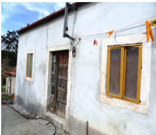
Figuras 196 – Fachada principal e cantarias degradadas.
