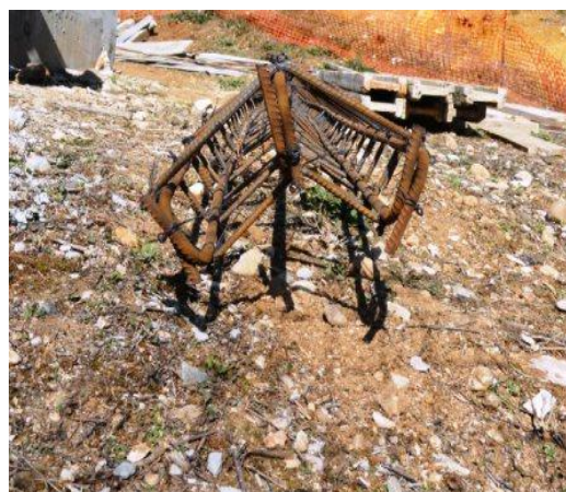
Figuras 48 – Vistas da armadura viga da cumeeira.
