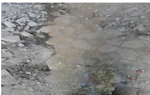
Figuras 8 – Estado do pavimento da capela-mor com mosaico de argila cozida.
