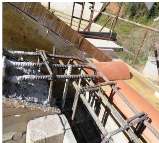
Figuras 47 – Colocação de armaduras e telhas de canudo no beirado.
