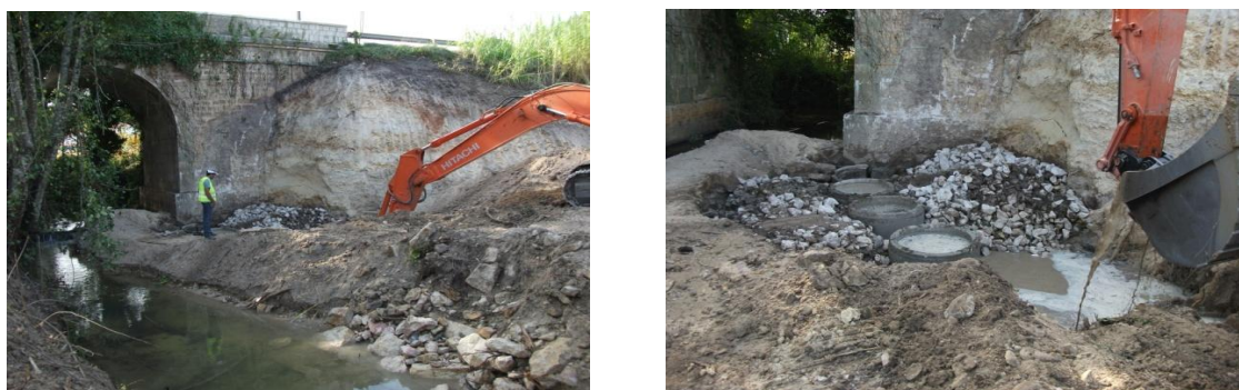
Figura 128 – Betonagem da fundação e reforço da zona da envolvente da fundação.
