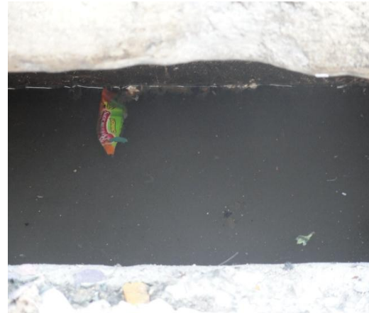
Figuras 161 – Sarjetas obstruídos com resíduos sólidos e com águas sujas paradas.
