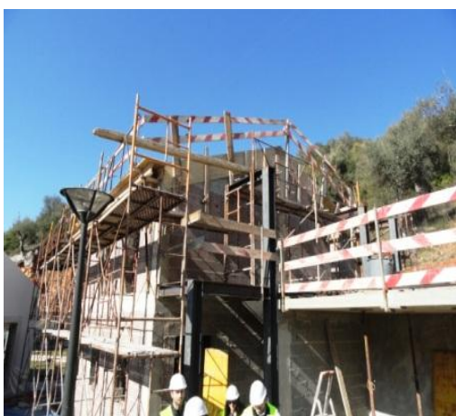
Figuras 44 – Vistas laterais da obra com cofragem em execução.
