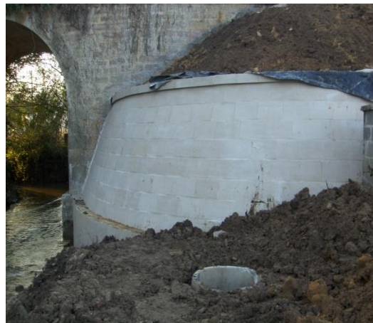
Figura 141 – Muro ala com inclinação e com 8 fiadas e rebordo de acabamento.
