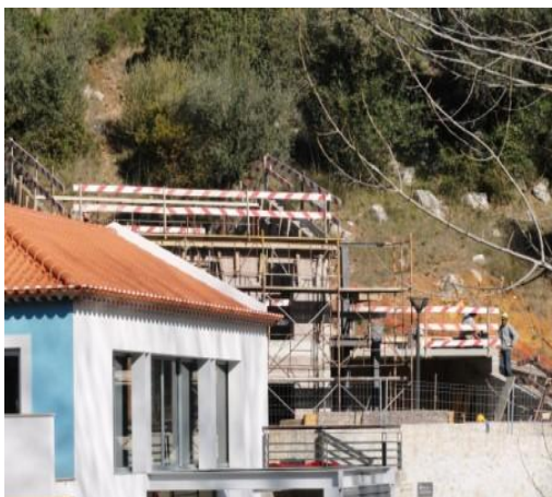
Figuras 43 – Colocação de guarda corpos em todo o perímetro da obra.
