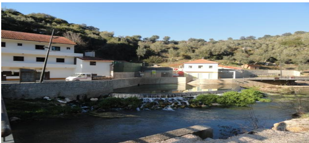
Figura 42 – Vista da piscina com edifício A já construído.
