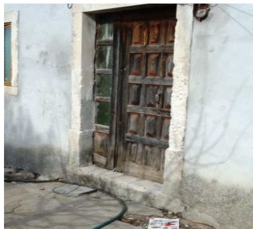
Figuras 196 – Fachada principal e cantarias degradadas.
