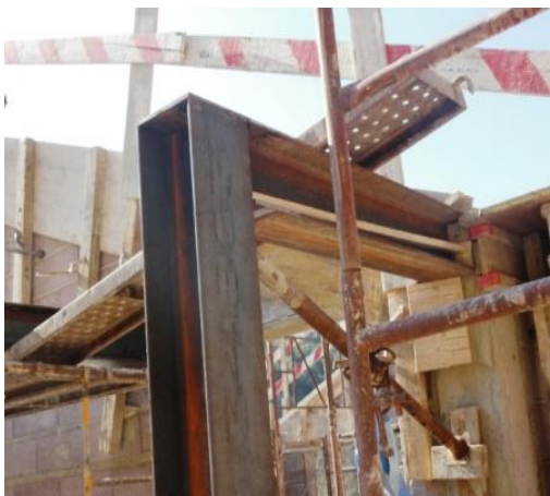
Figuras 49 – Ligações dos perfis metálicos.
