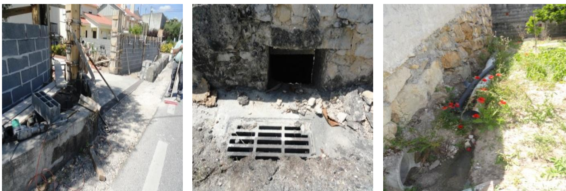
Figuras 189 – Local para aplicação de calçada e escoamento de águas pluviais.
