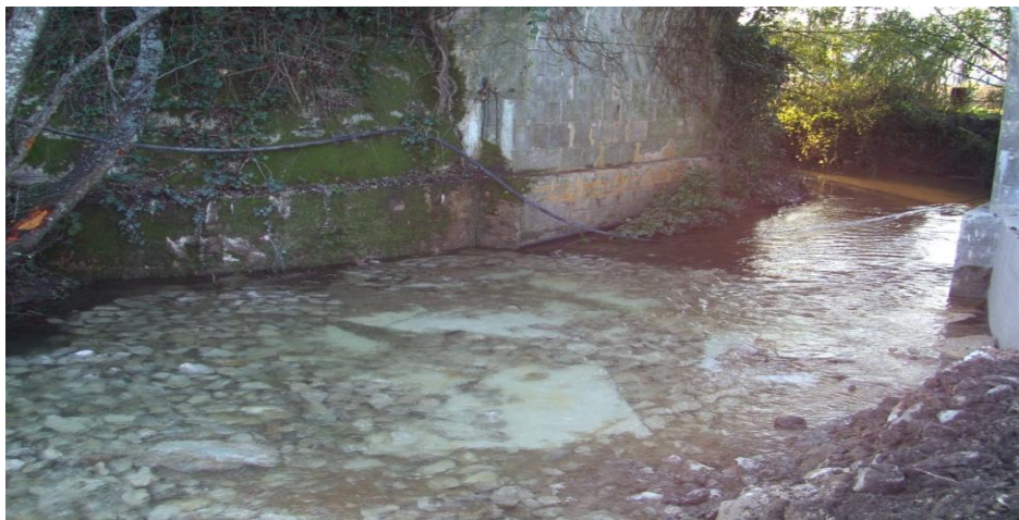
Figura 132 – Enrocamento do leito da ribeira.
