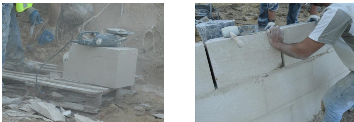
Figura 140 – Cortes, acertos e colocação dos blocos.
