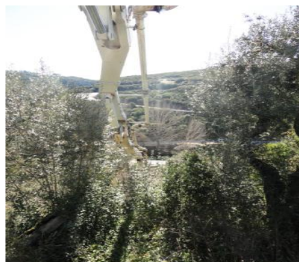
Figuras 55 – Aspectos da bomba de betonagem.
