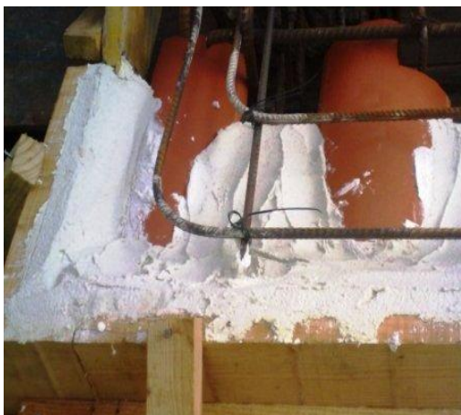
Figuras 53 – Pormenor construtivo do beirado.
