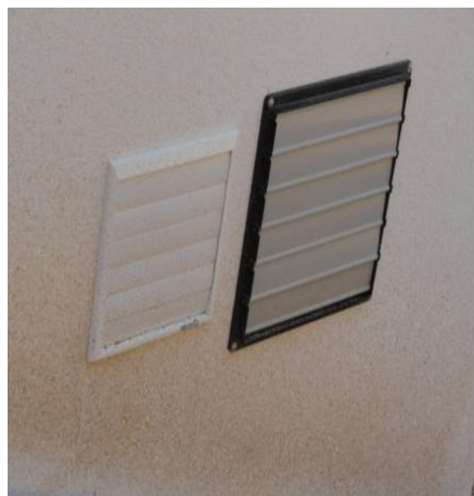
Figuras 87 – Entradas de ar no edifício, vistas pelo interior e pelo exterior.
