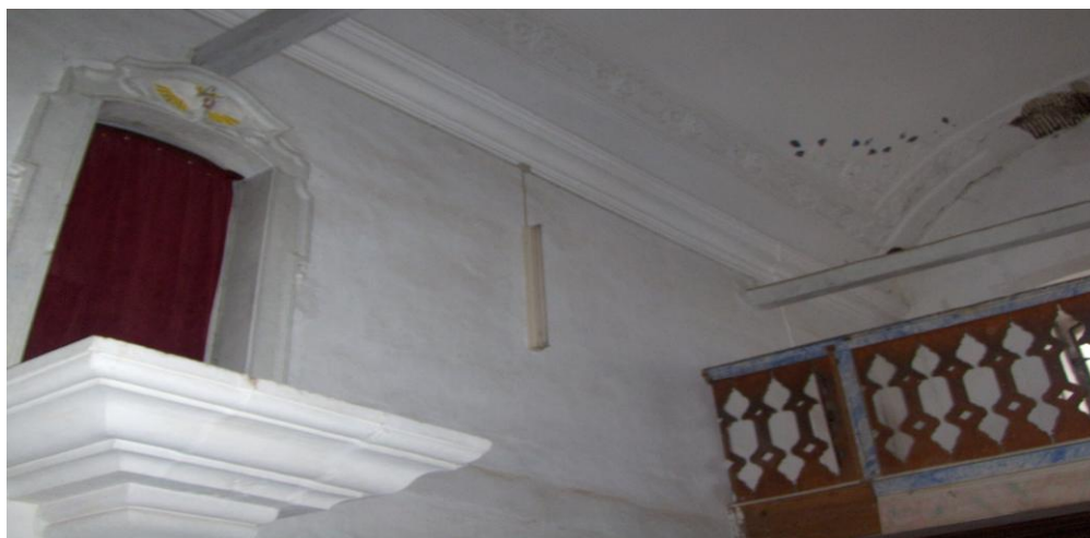
Figura 93 – Vão de acesso ao púlpito, exibindo na verga superior uma pomba.
