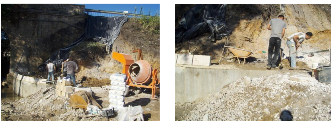
Figura 137 – Aspectos da obra.
