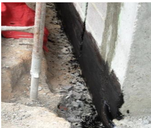
Figuras 67 – Preparação par receber sistema de isolamento “tipo Capoto”.
