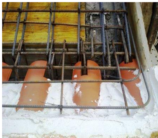
Figuras 53 – Pormenor construtivo do beirado.
