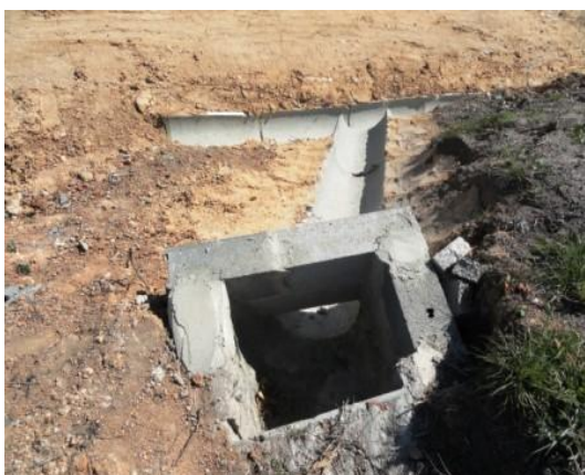
Figura 142 – Execução de caixas de visita e valetas em betão.
