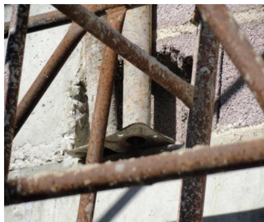
Figuras 45 – Escoramento do beirado com escoras metálicas e serra junta.
