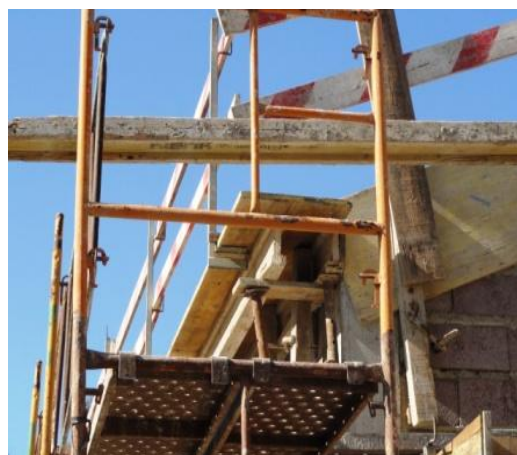
Figuras 46 – Início da cofragem da laje da cobertura.
