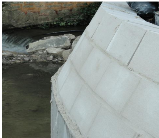
Figura 141 – Muro ala com inclinação e com 8 fiadas e rebordo de acabamento.
