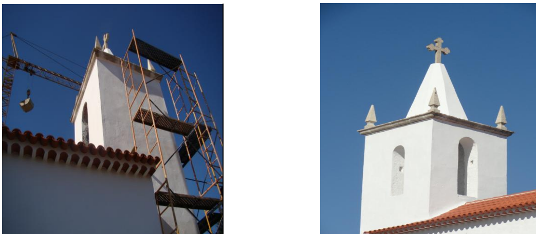
Figura 111 – Torre a ser intervencionada e depois de pronta.
