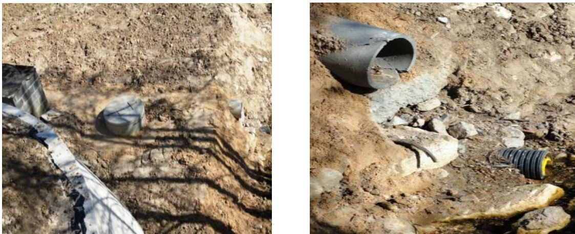
Figura 143 – Ligação dos drenos e águas pluviais á ribeira.
