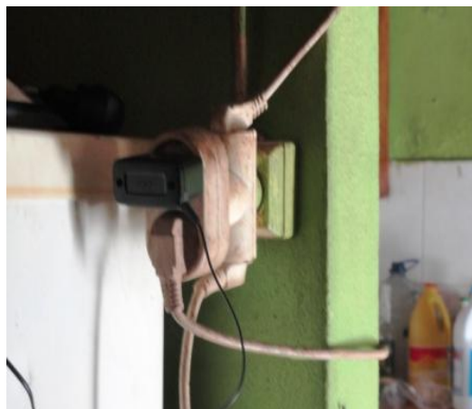
Figuras 198 – Instalação elétrica ativa sem condições de segurança.
