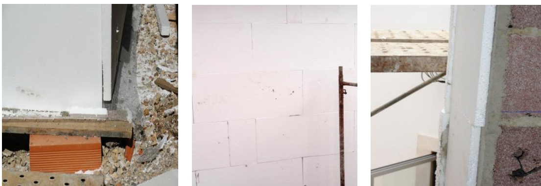
Figuras 71 – Pormenores de execução do isolamento
