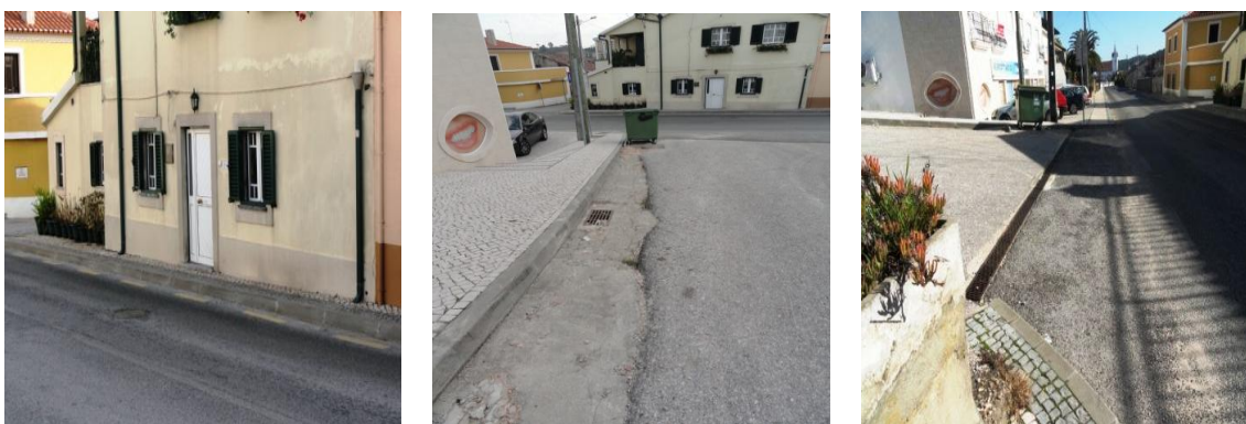
Figuras 169 – Localização do entroncamento da rua S. João e rua dos Combatente em Caxarias
