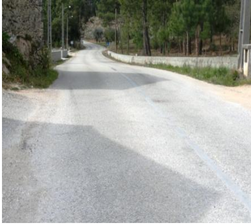
Figuras 146 – Patologia do pavimento mais visível, peladas.
