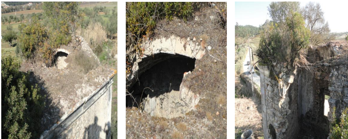
Figuras 17 – Vistas aéreas e lateral da abóbada da capela-mor
