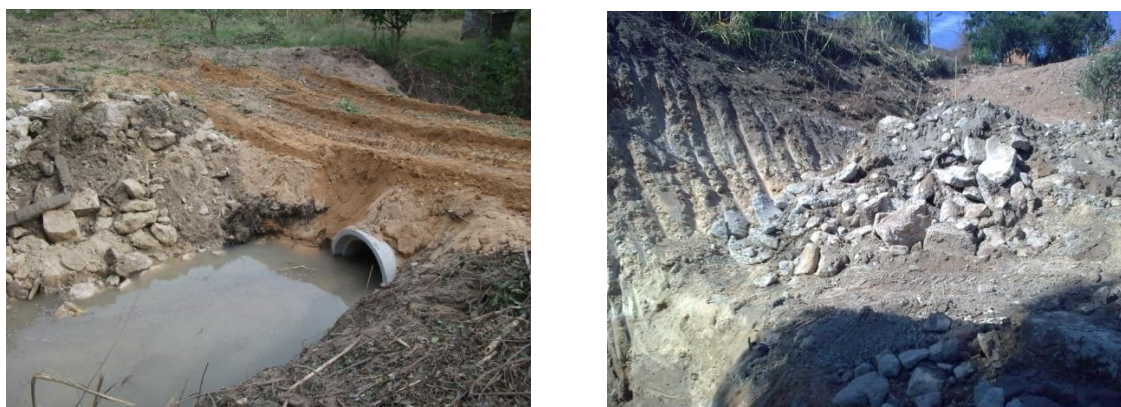
Figuras 126 – Passagem provisória entre as duas margens e preparação do acesso.
