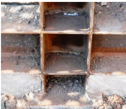
Figuras 59 – Soldaduras das ligações dos perfis.
