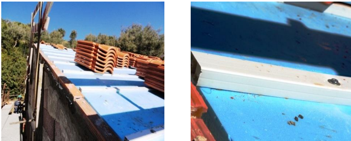
Figuras 62 – Execução da cobertura e detalhe da ripa.
