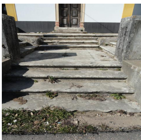
Figura 98 – a) Escadas em cantaria; b) Janela em cantaria.
