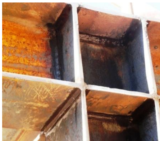
Figuras 59 – Soldaduras das ligações dos perfis.
