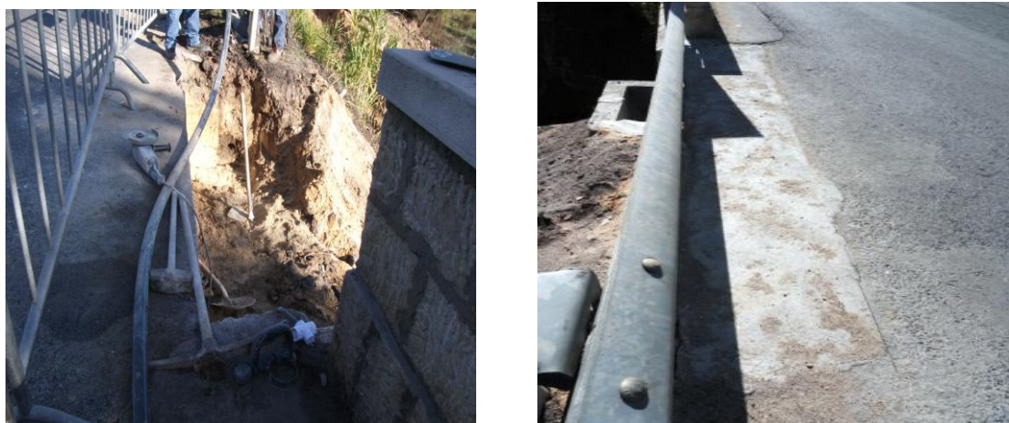
Figura 139 – Execução, reforço com viga junto á faixa de rodagem.
