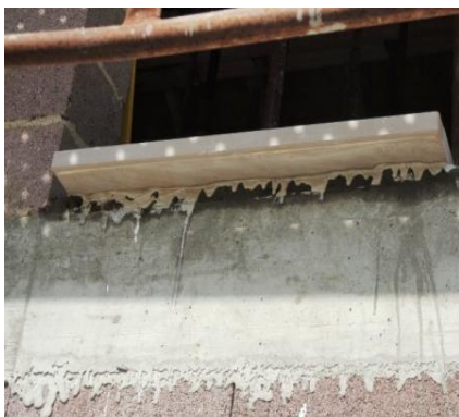
Figuras 66 – Assentamento de cantarias com nata de cimento branco.
