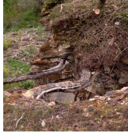
Figuras 29 – Raízes que provocaram a derrocada da parede lateral e parte da abóboda.
