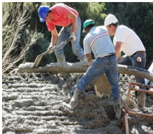
Figuras 58 – Betonagem da laje.
