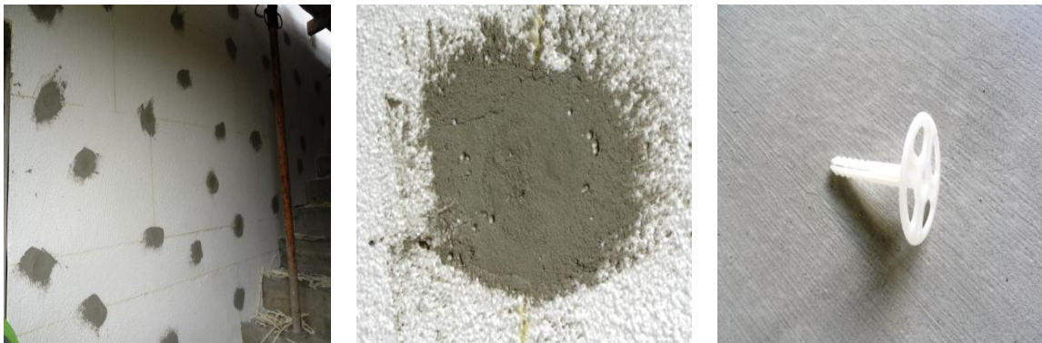
Figuras 72 – Fixação das placas EPS.
