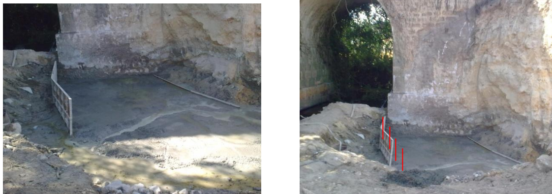
Figura 129 – Tapamento das manilhas com betão e colocação de varões de aço.
