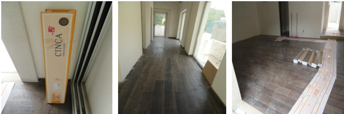
Figuras 81 – Aspectos do mosaico aplicado no pavimento no piso 1.
