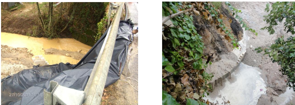
Figura 135 – Proteção do talude com plástico e vista panorâmica do muro ala.
