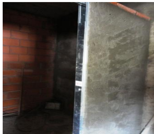
Figuras 64 – a) Execução de betonilha; b) Cassete para porta de correr.
