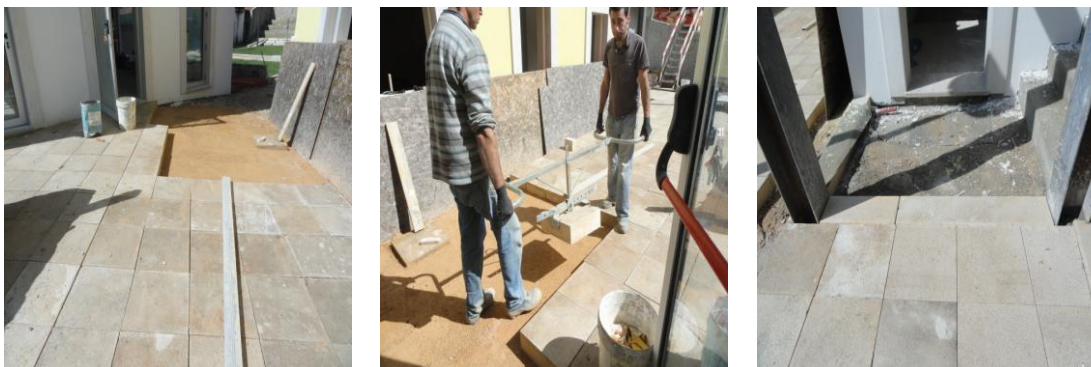
Figura 77 – Arranjos exteriores entre edifício A e B.
