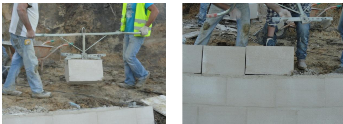
Figura 138 – Transporte e colocação dos blocos.
