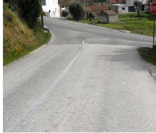
Figuras 146 – Patologia do pavimento mais visível, peladas.
