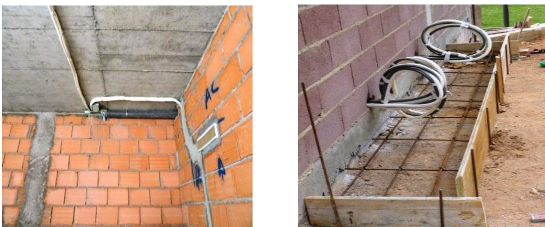
Figuras 69 – Colocação da tubagem para instalar sistema de climatização.
