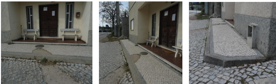
Figuras 176 – Entrada e passeio junto ao Centro de Saúde de Rio de Couros.
