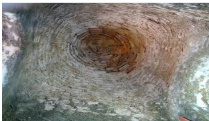
Figura 100 – Abóbada da torre sineira.
