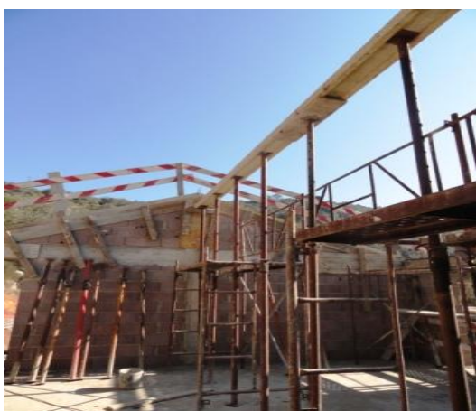
Figuras 46 – Início da cofragem da laje da cobertura.
