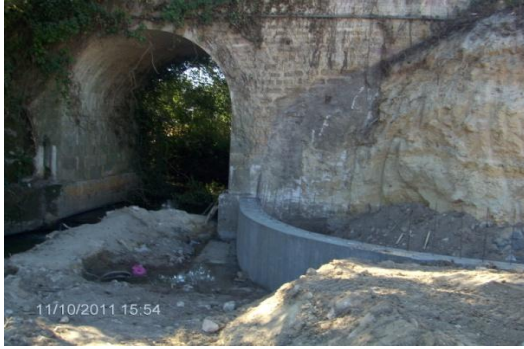
Figura 131 – Muro ala descofrado e colocação de tubo de dreno.
