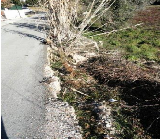
Figura 153 – Imagem da deslocação da berma com fissuração no pavimento betuminoso.
