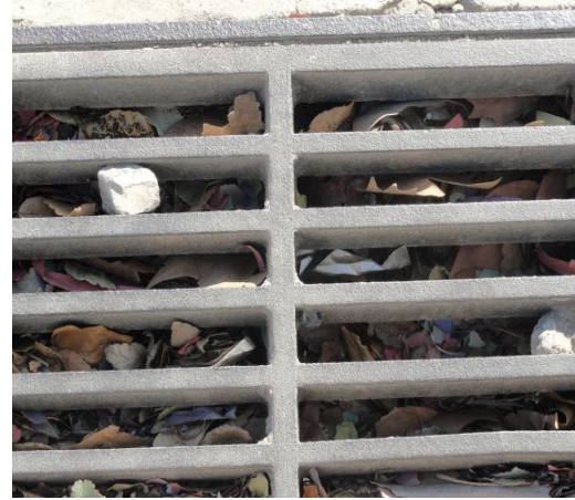
Figuras 160 – Rotunda na avenida D. Nuno Álvares Pereira com caixas de visita completamente entupida.
