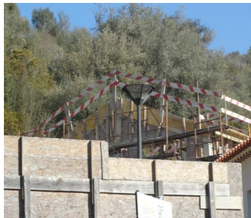
Figuras 43 – Colocação de guarda corpos em todo o perímetro da obra.
