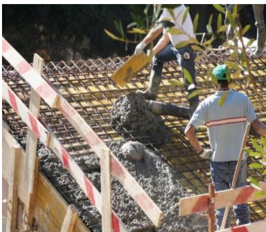
Figuras 57 – Início da betonagem da laje.
