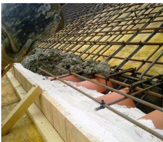
Figuras 54 – Aspectos da betonagem da cimalha do beirado.
