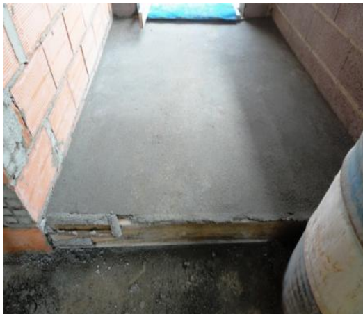
Figuras 64 – a) Execução de betonilha; b) Cassete para porta de correr.
