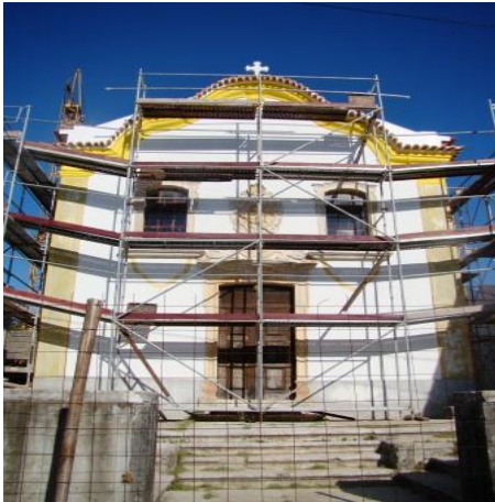
Figuras 112 – Instalação de andaimes e pormenores dos cunhais para pintar de ocre.
