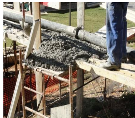
Figuras 56 – Plataforma de acesso á laje.
