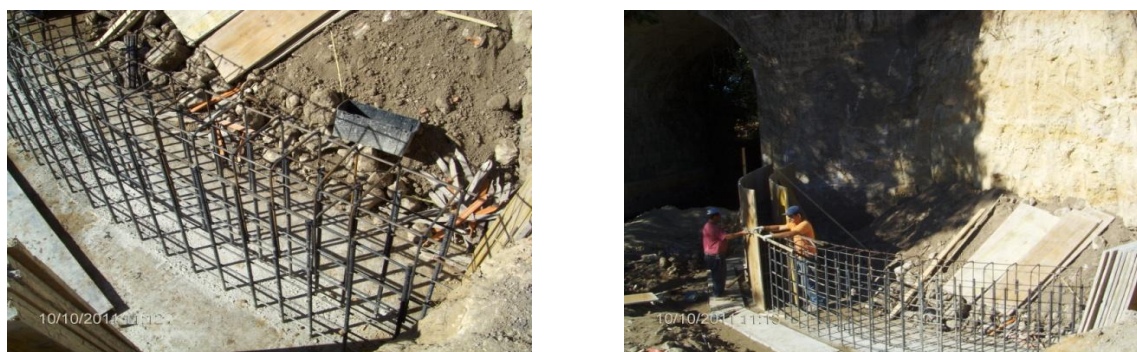
Figura 130 – Execução das armaduras em aço.
