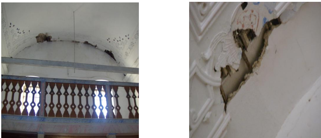
Figura 103 – Fragmentação do estuque do teto da abóbada.
