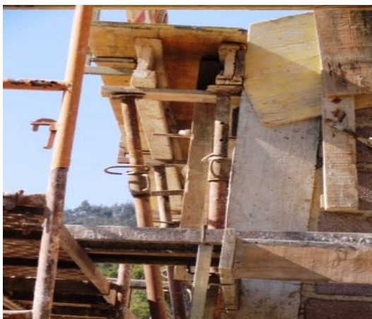
Figuras 45 – Escoramento do beirado com escoras metálicas e serra junta.
