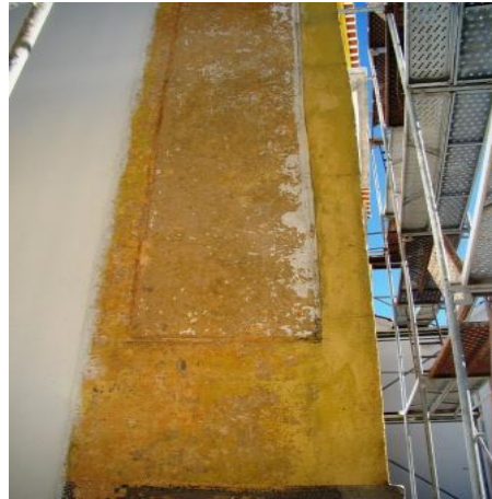
Figuras 112 – Instalação de andaimes e pormenores dos cunhais para pintar de ocre.
