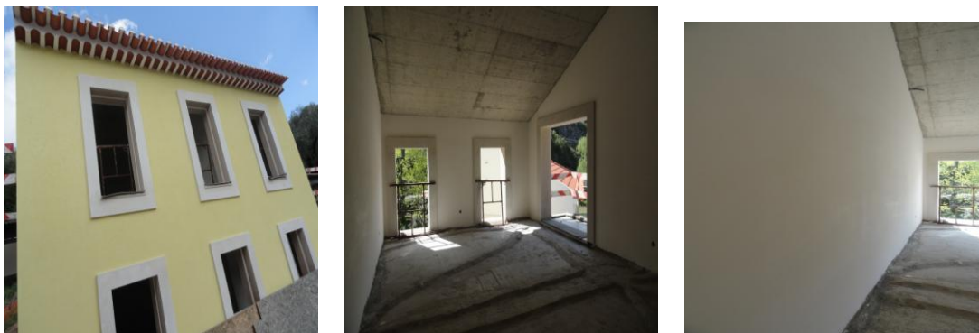
Figura 76 – Acabamento no exterior e interior do edifício
