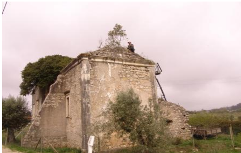
Figuras 30 – Corte da vegetação na cobertura.
