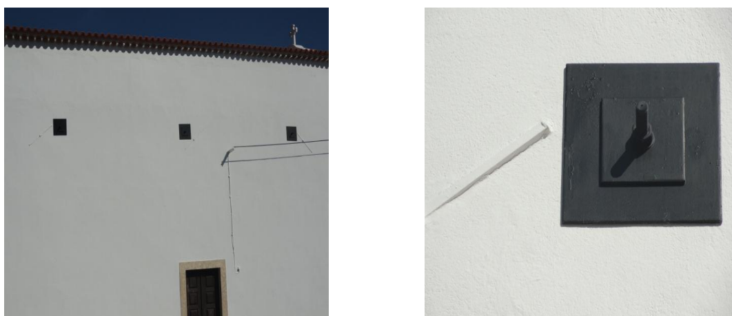
Figura 109 – Amarração de tirantes nas paredes estruturais na nave principal.
