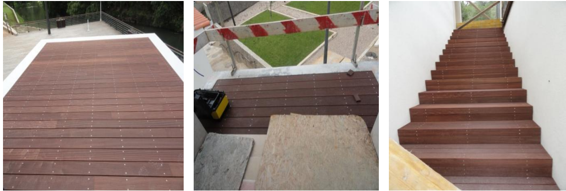
Figura 80 – Colocação de deck nas varandas e na escada.
