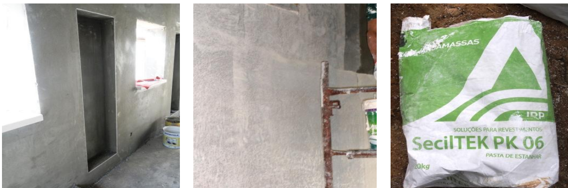
Figuras 74 – Acabamento dos paramentos interiores.
