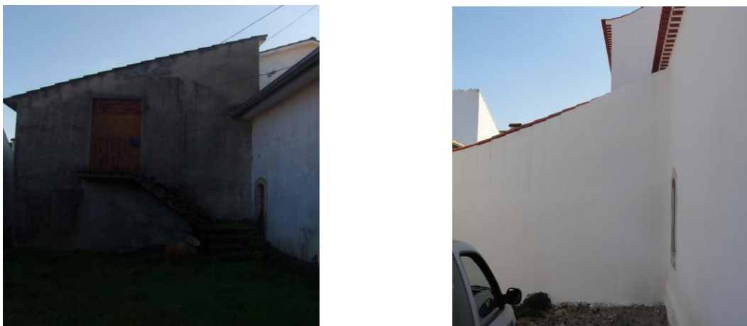
Figura 110 – Remoção da escada de betão para acesso de coro-alto e rebaixamento do anexo.
