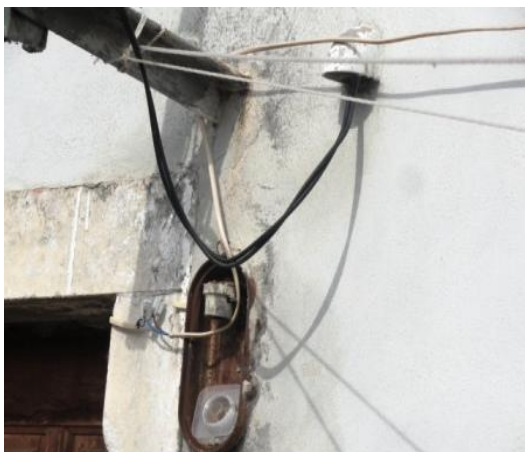
Figuras 198 – Instalação elétrica ativa sem condições de segurança.
