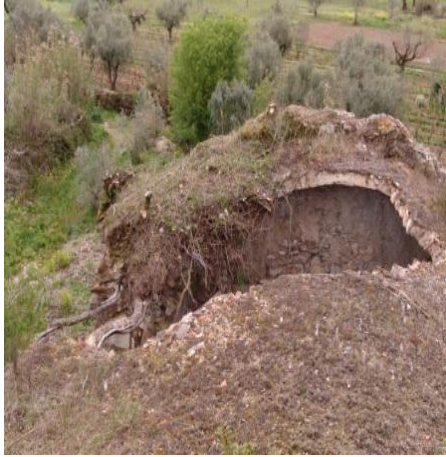
Figuras 29 – Raízes que provocaram a derrocada da parede lateral e parte da abóboda.
