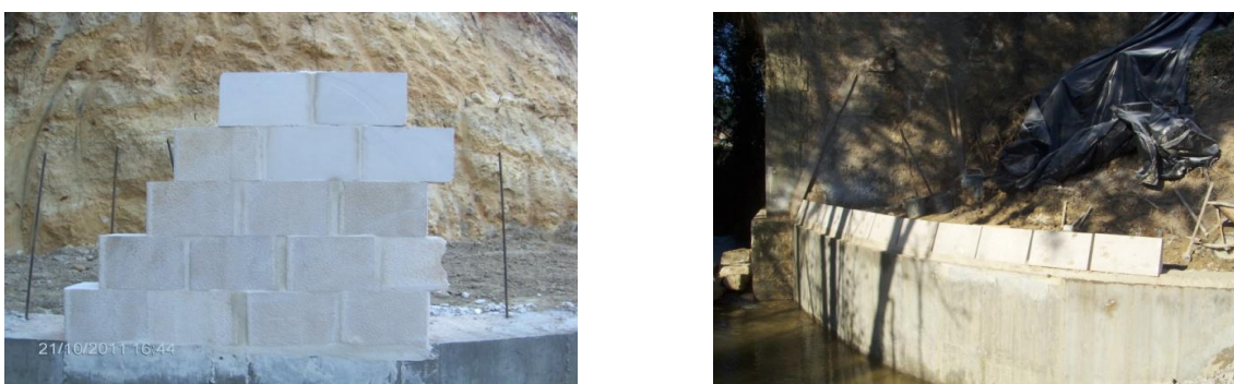
Figura 136 – Demonstração de aplicação dos blocos de calcário.
