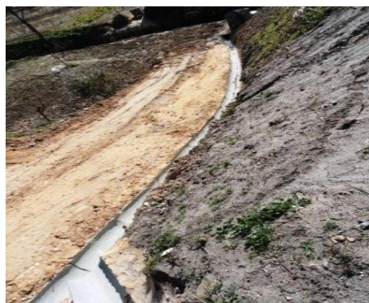
Figura 142 – Execução de caixas de visita e valetas em betão.
