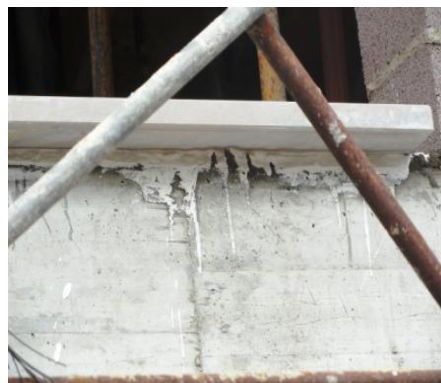
Figuras 66 – Assentamento de cantarias com nata de cimento branco.
