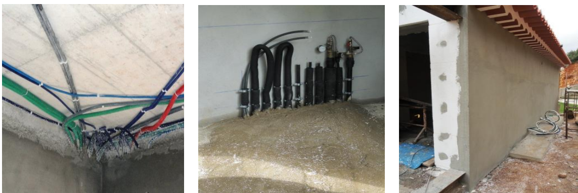
Figura 75 – Pré-instalação de tubagem até à casa das máquinas.
