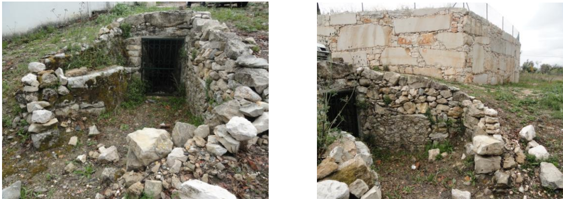
Figuras 174 – Alvenaria de pedra e pedra solta da “Fonte dos Sapos”
