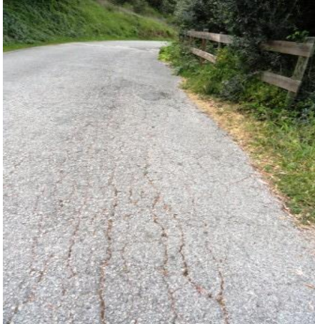
Figuras 184 – Fissuração do pavimento e talude a proteger.
