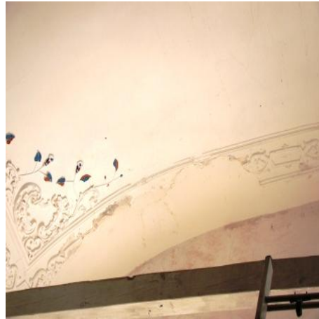
Figuras 117 – Reparação da abóbada da nave com estuque (antes da intervenção e detalhe durante a intervenção).
