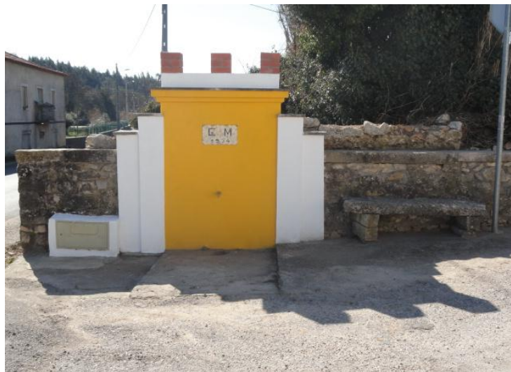
Figura 118 – Fonte reabilitada junto à capela.
