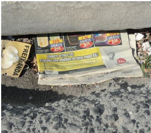
Figuras 161 – Sarjetas obstruídos com resíduos sólidos e com águas sujas paradas.
