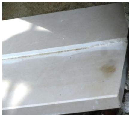
Figuras 65 – Assentamento de cantarias nas soleiras e rebaixo da pedra.
