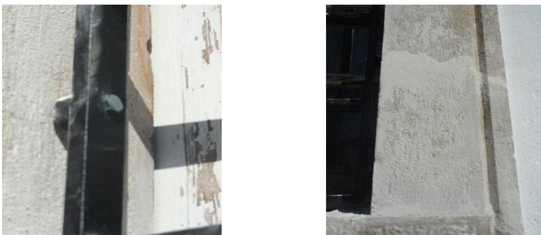
Figura 114 – Pormenor da fixação da grade e recuperação da pedra calcária da janela.
