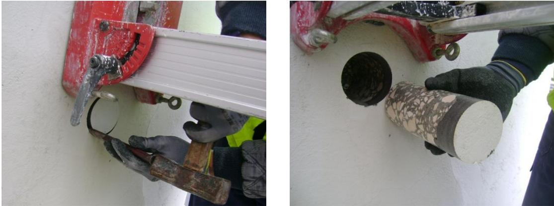
Figura 20 - Remoção de uma carote.
