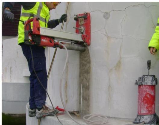
Figura 19 - Caroteadora em funcionamento.
