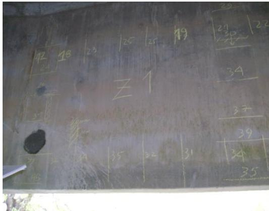
Figura 62 - Traçado dos varões na superfície de betão com o registo dos recobrimentos (Z.1).
