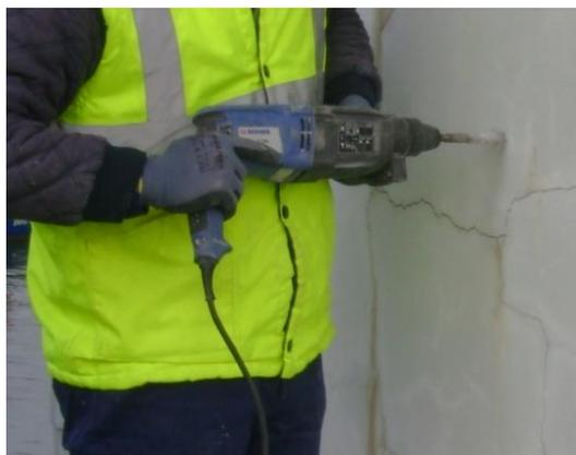
Figura 17 - Execução do furo para fixar a caroteadora.
