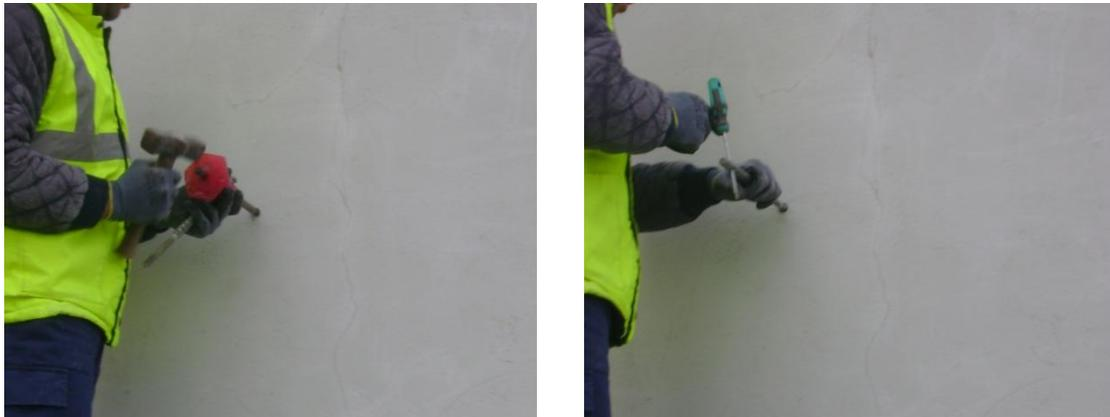
Figura 18 - Batimento da bucha metálica e aparafusamento do perne.
