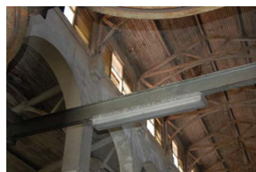
Figura 107 - Pormenor das asnas a manter e a reabilitar
