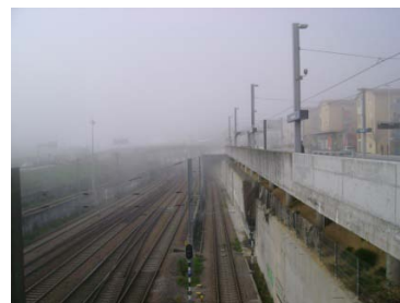
Figura 76 - Vista da linha ferroviária em Contumil - Porto
