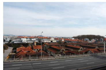
Figura 93 - Panorâmica do edificado
