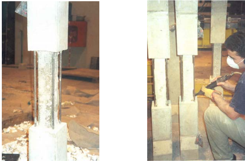
Figura 5 – Aspecto da superfície do pilar após a retirada do poliestireno expandido (1) e preparação da superfície, a ser reparada, com martelo de agulhas.
