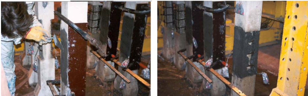
Figura 6 – Reparação dos pilares.
