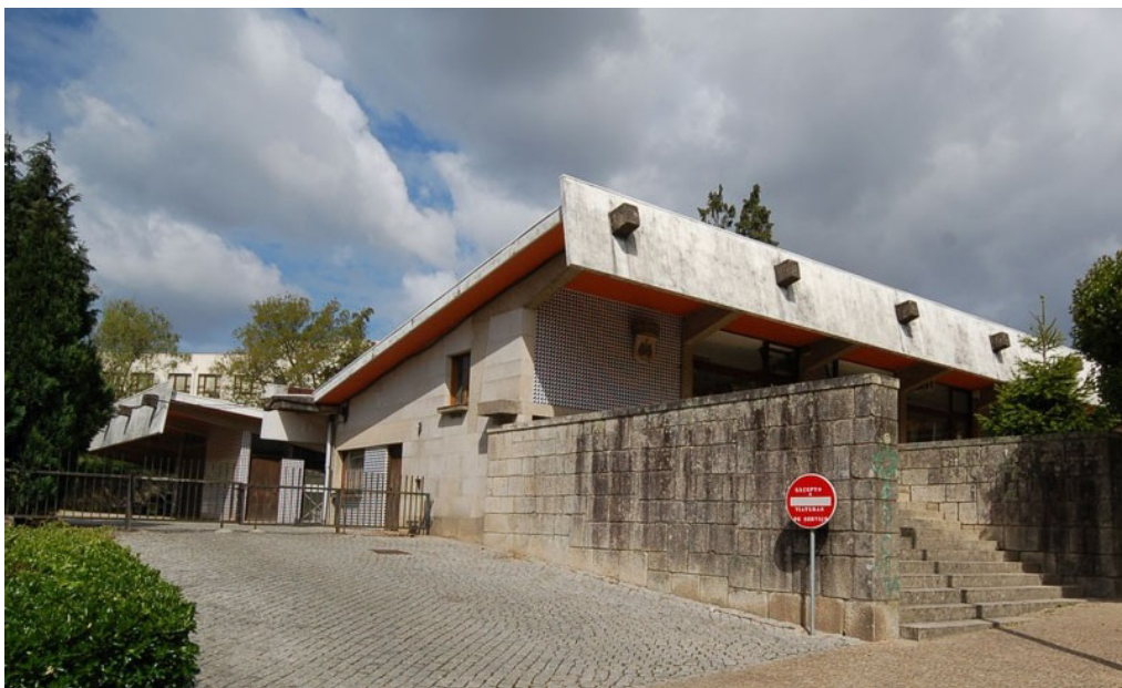
7- Pavilhão de ténis da Quinta da Conceição - Fernando Távora, 1956-60
