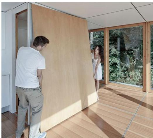
Fig.66&gt; Colocação dos painéis interiores
