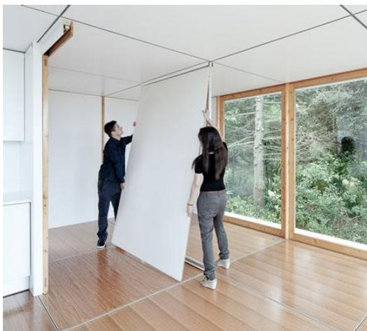
Fig.65&gt; Colocação dos painéis interiores
