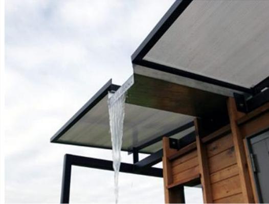
Fig.26&gt; Telhado de recolha de água da chuva
