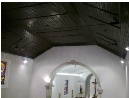
Figura 90 – Tirantes ao nível da cobertura reforçando a ligação entre paredes opostas.
