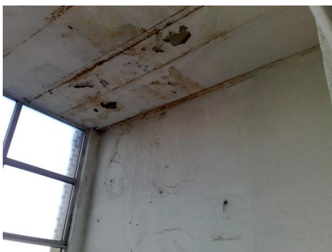
Figura 19 – Pavimento de varandas em vigas de ferro e tijolo cerâmico.
