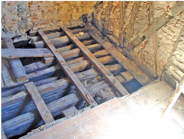
Figura 20 – Vigas de pavimento em madeira com andar de ressalto [Appleton, J.; 2008].
