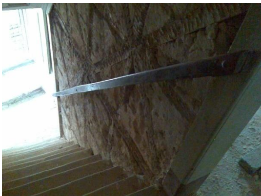
Figura 30 – Paredes de caixa de escadas de frontal pombalino.
