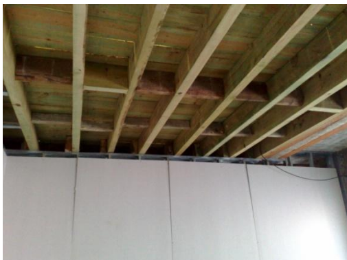
Figura 122 – Tarugamento de pavimento de madeira.
