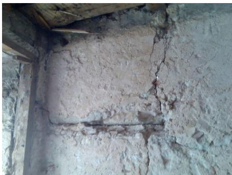
Figura 88 – Fenda numa parede, onde se deve efetuar a sondagem.
