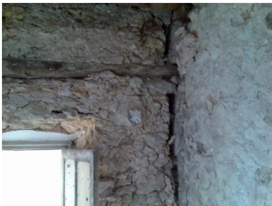
Figura 85 – Deslocamento entre paredes convergentes.
