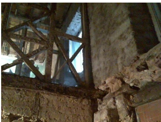
Figura 86 – Fachada deslocada para o plano exterior.
