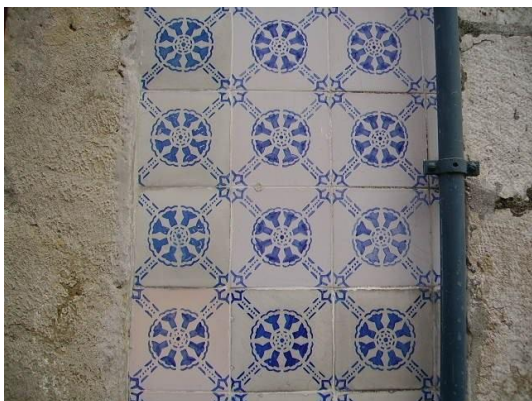
Figura 41 – Fachada revestida a azulejo.
