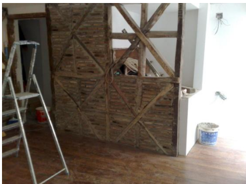
Figura 106 – Reconstrução de parede de frontal pombalino.
