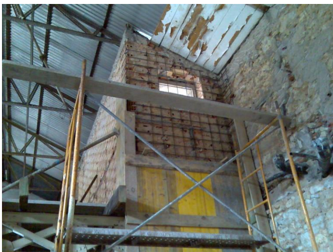
Figura 89 – Reforço de parede através da aplicação de uma armadura, com fixação através de conetores e posterior lâmina de betão.
