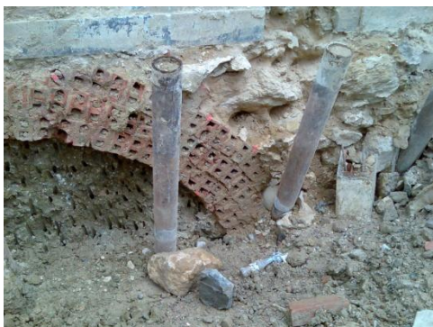
Figura 11 – Arco de fundação de alvenaria.
