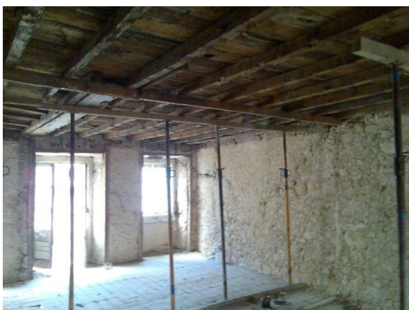
Figura 5 – Vigamento perpendicular às fachadas principais.
