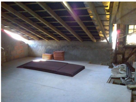
Figura 128 – Aplicação de subtelha de modo a proteger eventuais infiltrações.
