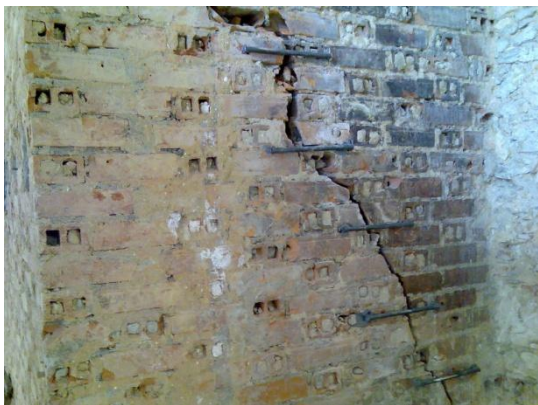
Figura 105 – Aplicação de “gatos” numa fenda.
