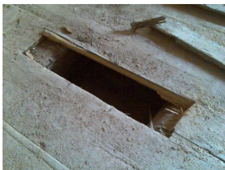
Figura 110 – Remoção do soalho de modo a inspecionar o estado do vigamento.
