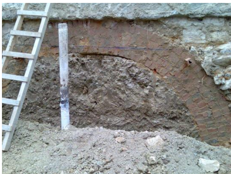
Figura 12 – Arco de fundação em alvenaria onde se pode verificar o perfeito aparelhamento das pedras.
