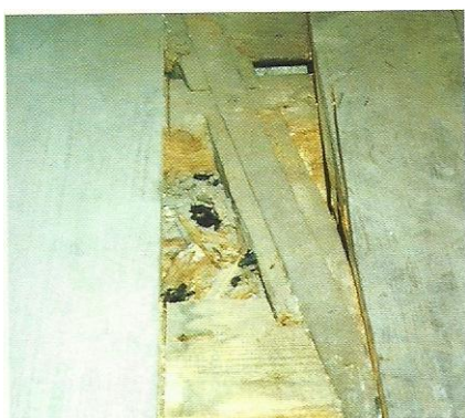
Figura 119 – Reforço de ligação entre paredes e pavimentos através de elementos metálicos [Appleton, J.; 2003].
