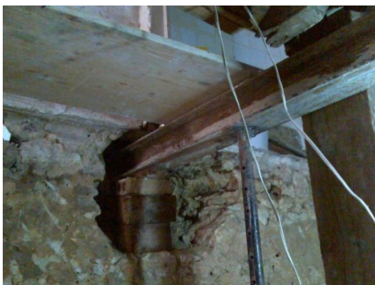
Figura 43 – Remoção de paredes resistentes com substituição por perfis metálicos.
