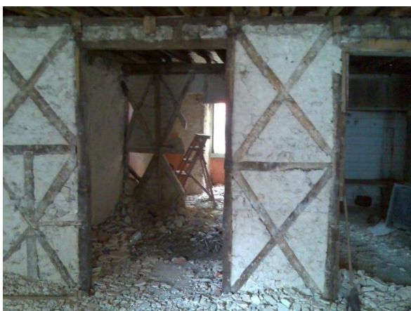
Figura 23 – Parede de cruz de Santo André com preenchimento de alvenaria de pedra e abertura para vãos de portas.
