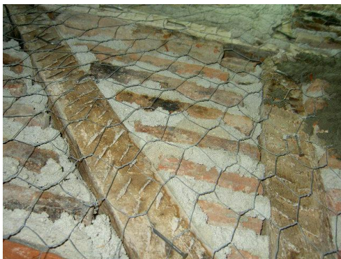
Figura 108 – Aplicação de rede de capoeira, não é a mais indicada devido à deformação que apresenta.
