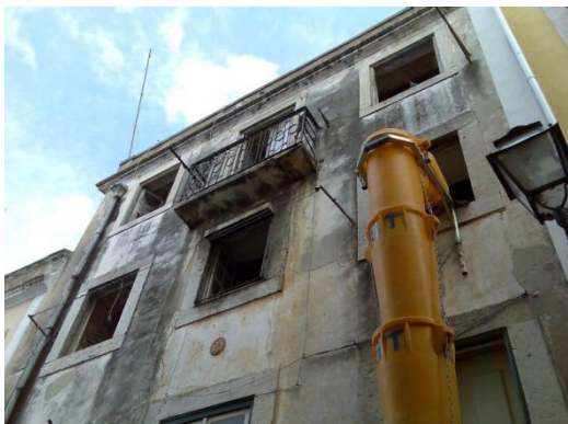
Figura 33 – Cantarias nos contornos dos vãos demonstrando qualidade construtiva.
