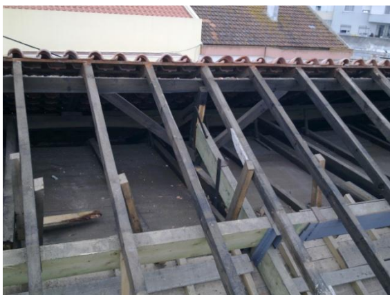
Figura 27 – Utilização de elementos metálicos para reforço da estrutura de uma cobertura.
