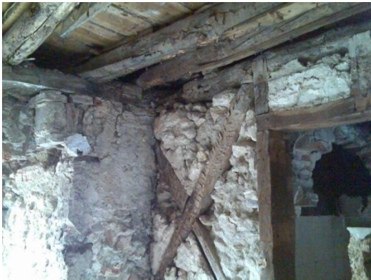
Figura 117 – Vigas apoiadas em frechal.
