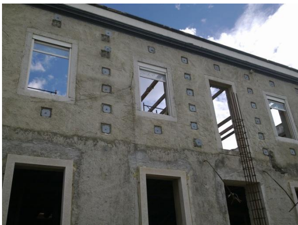
Figura 98 – Reforço de ligação entre paredes através da aplicação de varões metálicos.
