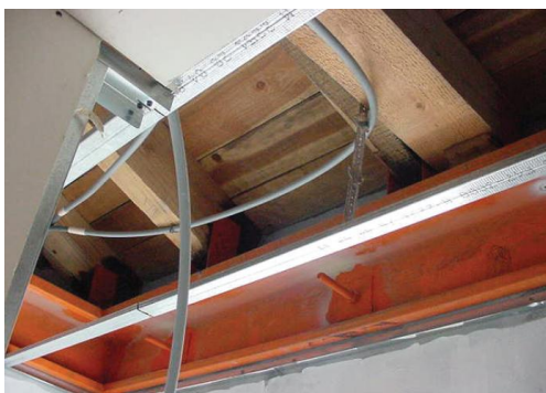
Figura 96 – Pormenor de ligação da cantoneira à parede envolvente [Costa, A.; 2008].
