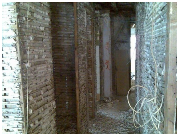
Figura 7 – Paredes divisórias interiores de tabique de prancha ao alto fasquiado.
