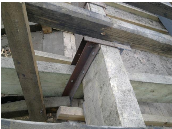
Figura 126 – Reforços metálicos nas ligações entre os elementos das asnas.
