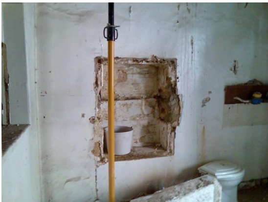
Figura 52 – Abertura de um buraco numa parede resistente para aproveitamento de espaço.
