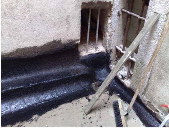
Figura 81 – Ralo de escoamento de águas pluviais enterrado no solo.
