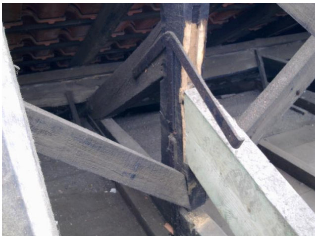
Figura 8 – Utilização de ligação metálica em asna de cobertura.
