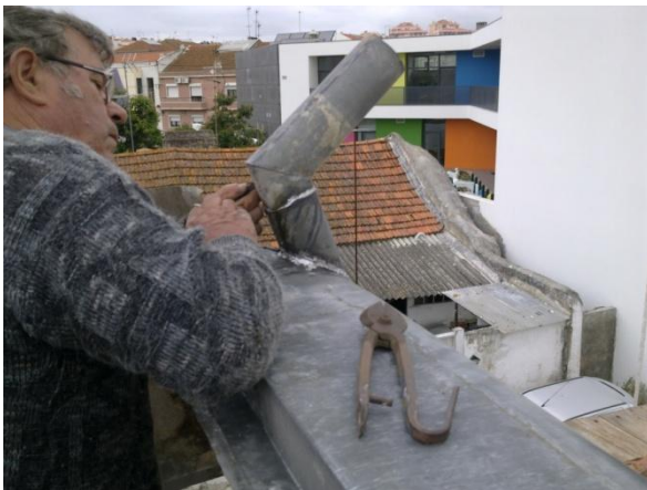
Figura 69 – Restauro de caleira e tubo de queda em zinco.
