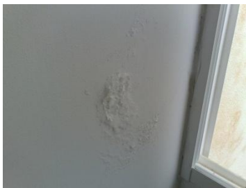
Figura 75 – Aplicação de pintura impermeável numa parede de alvenaria de pedra.
