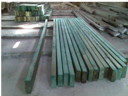
Figura 107 – Elementos de madeira em fase de tratamento anti-fungos e anti-caruncho.
