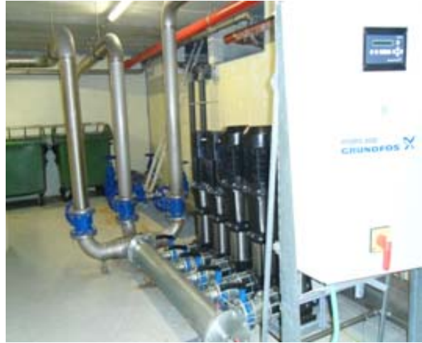
Tubagens de abastecimento da rede
