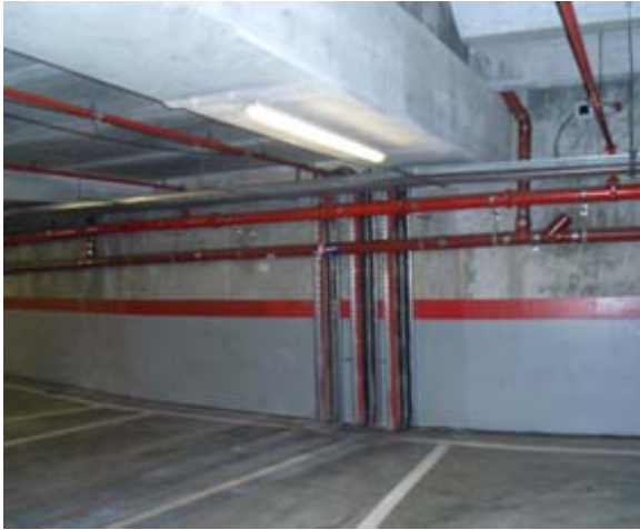
Tubagens de drenagem e abastecimento da rede
