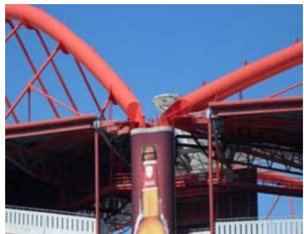
Pormenor da cobertura
