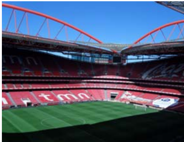
Vista geral sobre as bancadas do estádio
