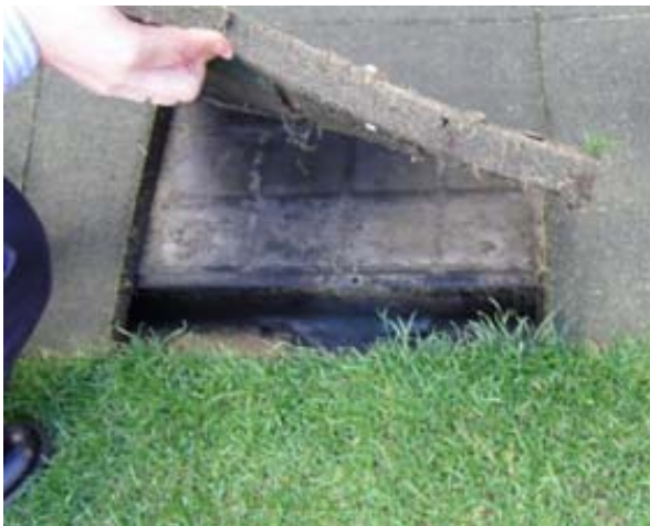
Pormenor da caleira circundante ao relvado
