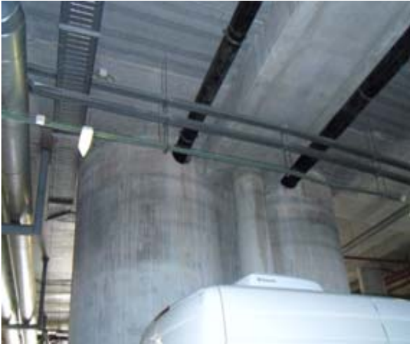
Tubagem de saída dos pilares
