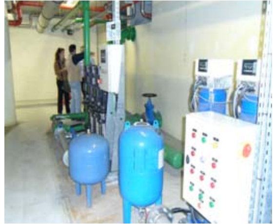
Circuito/controlo de abastecimento da rede
