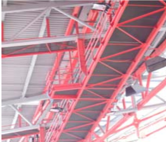
Pormenor da calha técnica de acesso a cobertura
