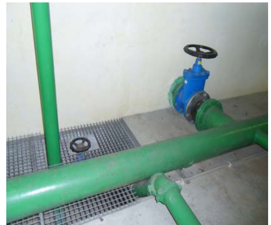
Válvulas de corte
