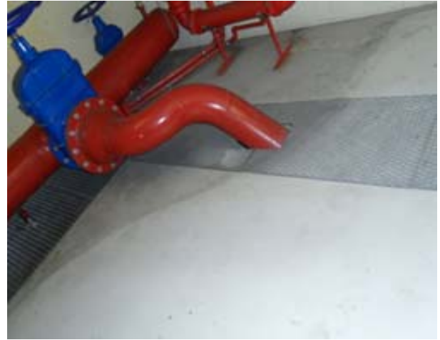
Ligação da tubagem entre reservatórios
