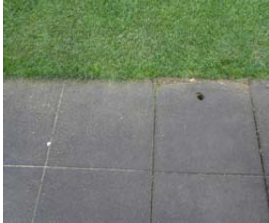
Pavimento circundante ao relvado
