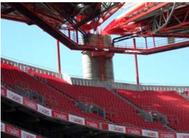
Pilares com ligação das tubagens à cobertura
