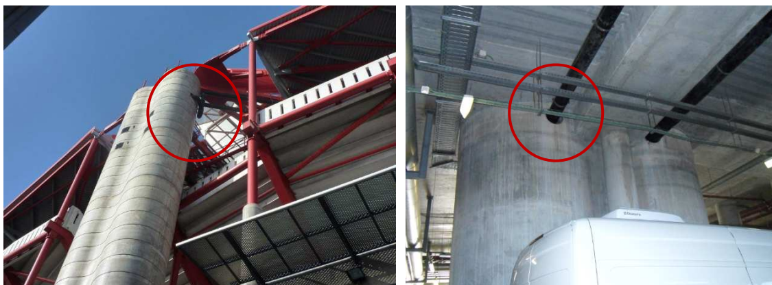
Imagem IV.10 e IV.11 - Pormenores da entrada e saída das tubagens nos pilares
