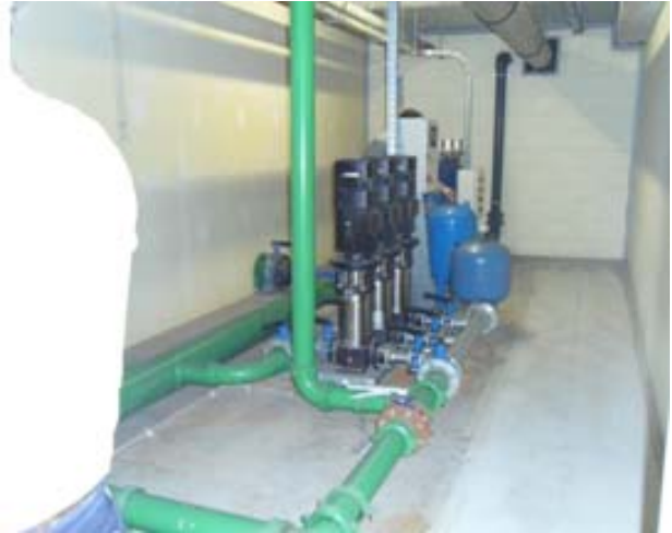
Circuito/controlo de abastecimento da rede
