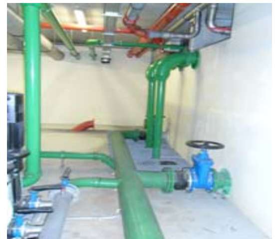
Tubagens de abastecimento da rede
