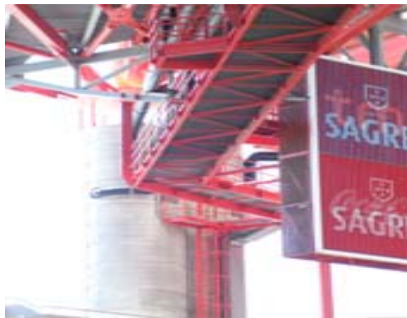
Entrada da tubagem nos pilares
