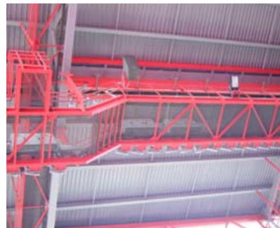
Pormenor da calha técnica
