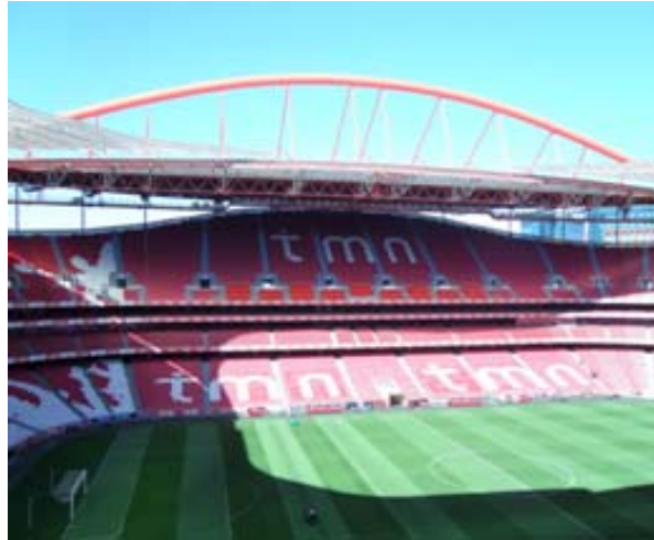
Vista geral sobre as bancadas do estádio
