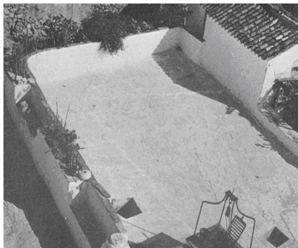
Imagem II.15 – Eirado onde são visíveis orifícios que comunicam com a cisterna [3.03]
