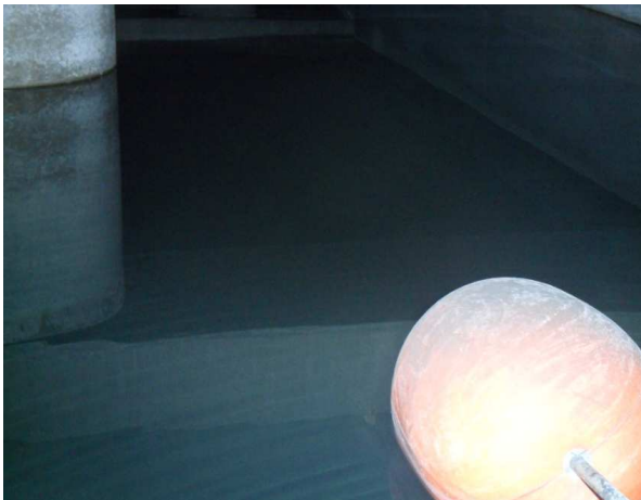
Imagem IV.23 e 24 – Controlo de quantidade de água armazenada através de boia
