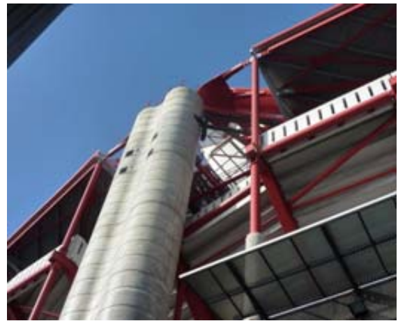
Pilares de acesso à Cave 2
