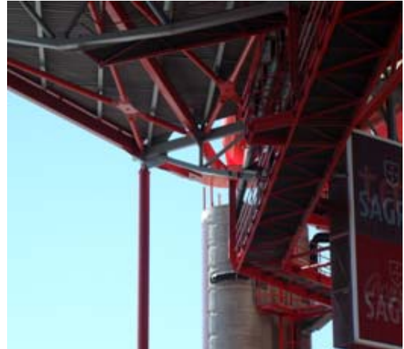
Pormenor da tubagem a entrar no pilar
