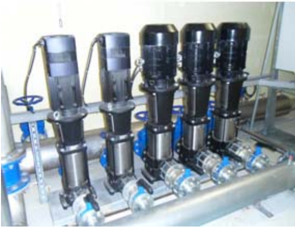
Tubagens de abastecimento da rede
