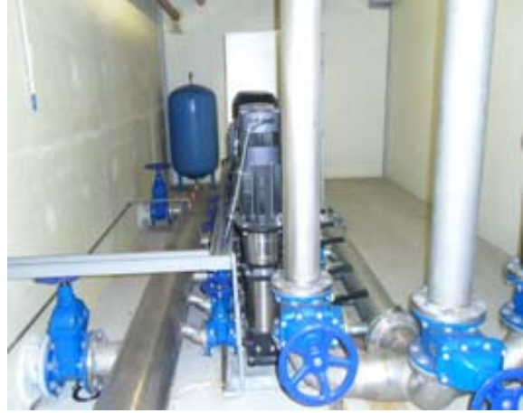
Tubagens de abastecimento da rede
