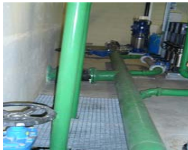
Circuito/controlo de abastecimento da rede
