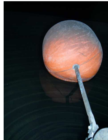
Imagem IV.23 e 24 – Controlo de quantidade de água armazenada através de boia
