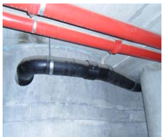
Pormenor da saída da tubagem do pilar
