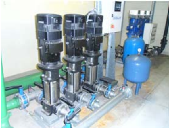
Circuito/controlo de abastecimento da rede
