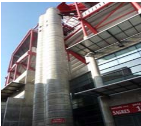
Pilares de acesso à Cave 2
