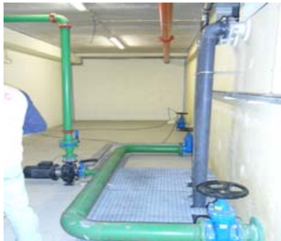
Tubagens de abastecimento da rede
