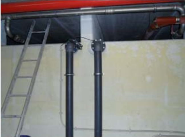
Vista para entrada no reservatório
