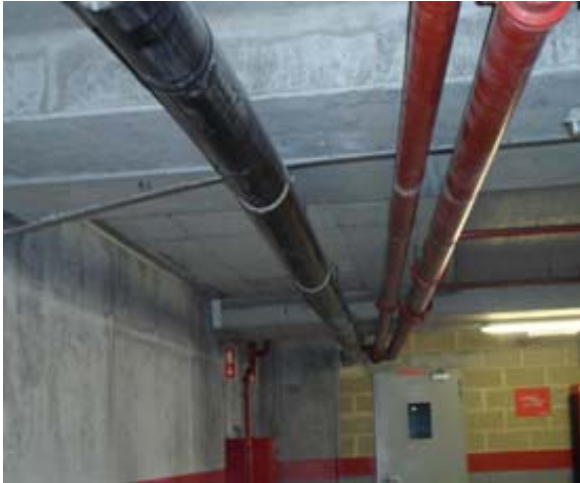
Encaminhamento das águas para o reservatório
