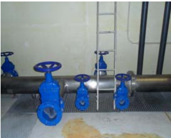
Tubagens de abastecimento da rede
