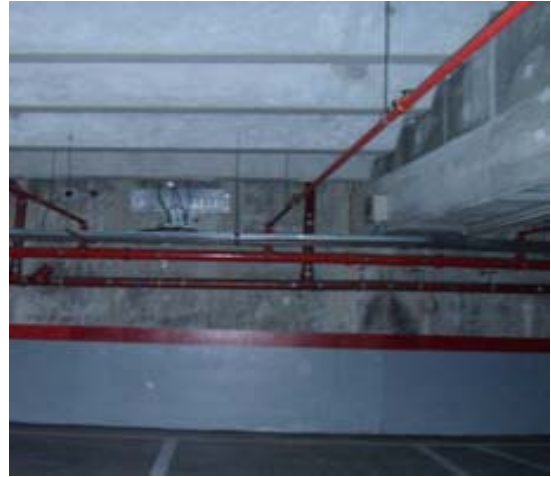
Tubagens de drenagem e abastecimento da rede
