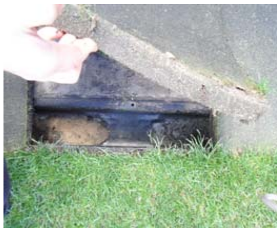
Pormenor da caleira circundante ao relvado
