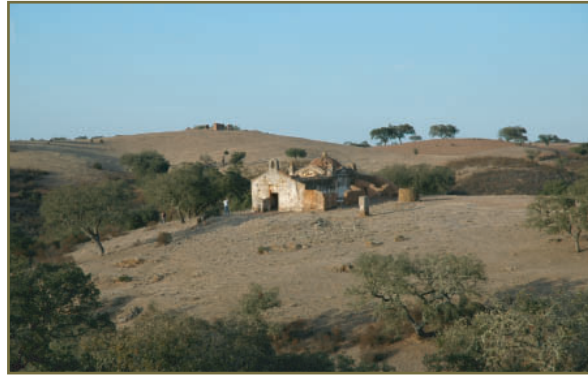
Fig. 4 - Vista geral da Capela de São Lourenço
