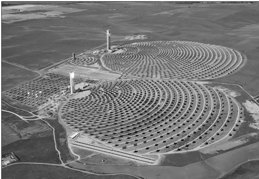
Figura 8 Solúcar PS-10, PS-20 (Abengoa)
