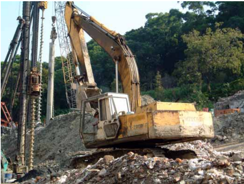
圖 2 坡址地帶排樁施工圖示
