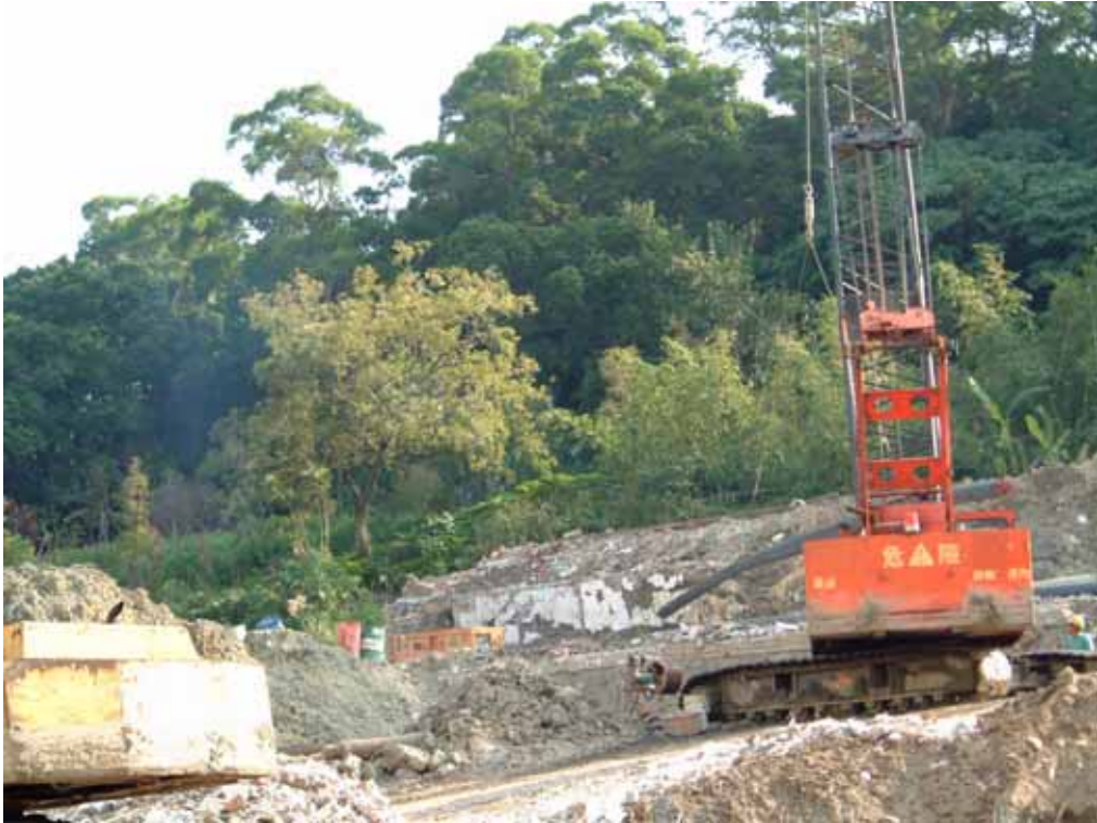
圖 1 現場整地作業施工圖示
