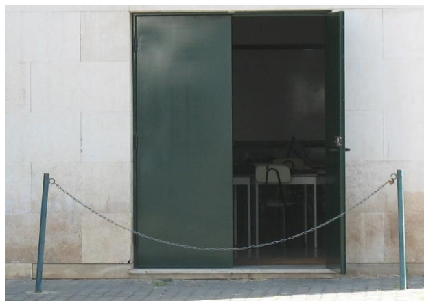
Figura 43 - Pormenor da entrada do Laboratório de Hidráulica.
