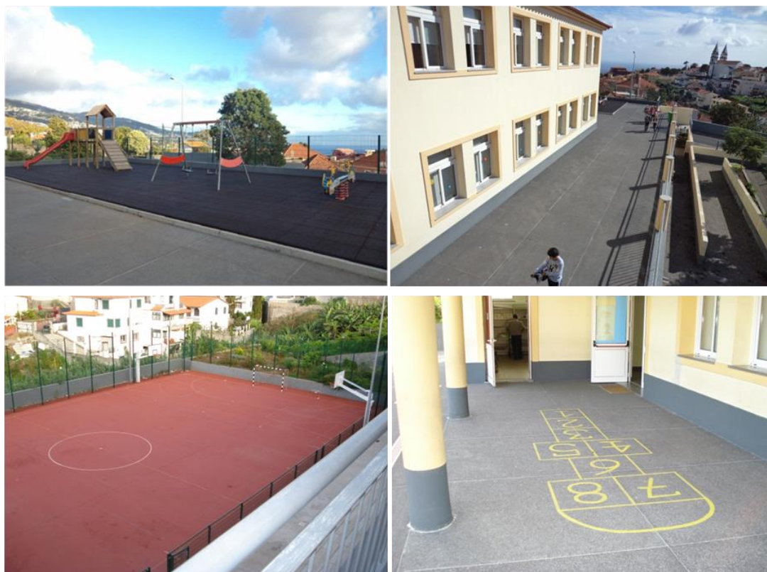
Figura 35. Espaços exteriores da EB1/PE da Ladeira
