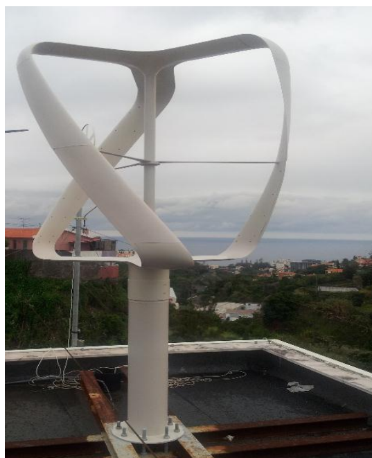
Figura 3.7 – Turbina Darrieus do kit PRAMAC 1 kW instalado na Universidade da Madeira.
