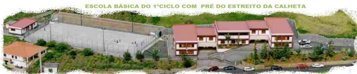
Ilustração 1 Imagem geral do aspecto exterior do edifício.
