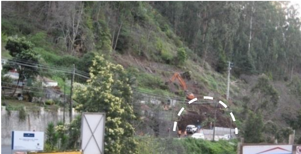
Figura 7.2: Zona do emboquilhamento poente.
