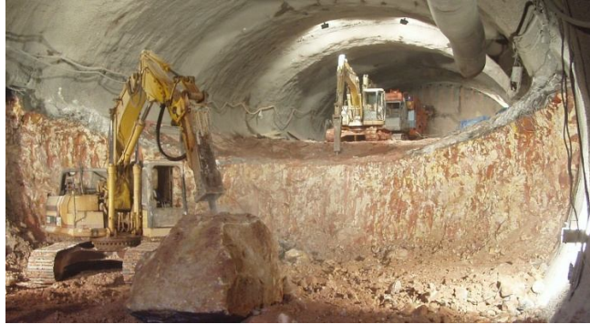
Figura 5.61: Rebaixo de um túnel (adaptado de Laabmayr.at).
