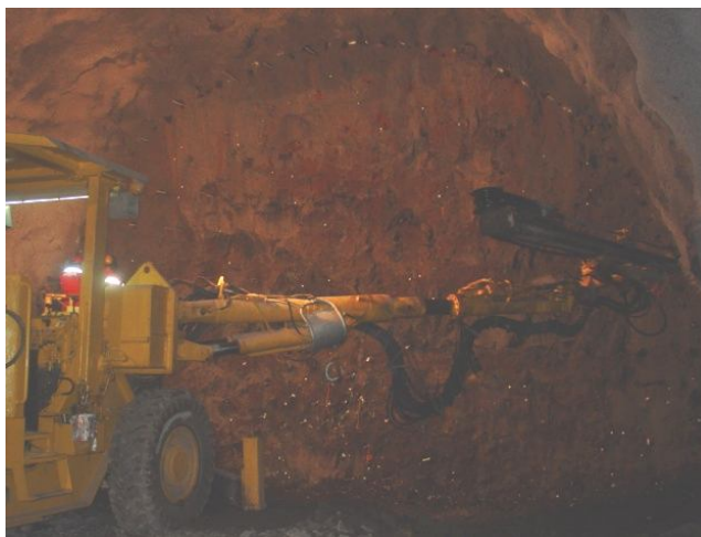
Figura 5.49: Carregamento de uma pega de fogo.
