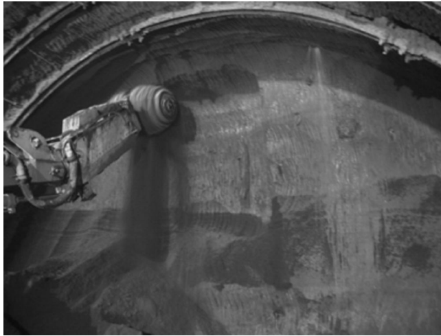
Figura 8.2: Cabeça roçadora acoplada a uma escavadora hidráulica no emboquilhamento ponte do acesso oeste ao porto do Funchal (adaptado de BENTO et al , 2003).
