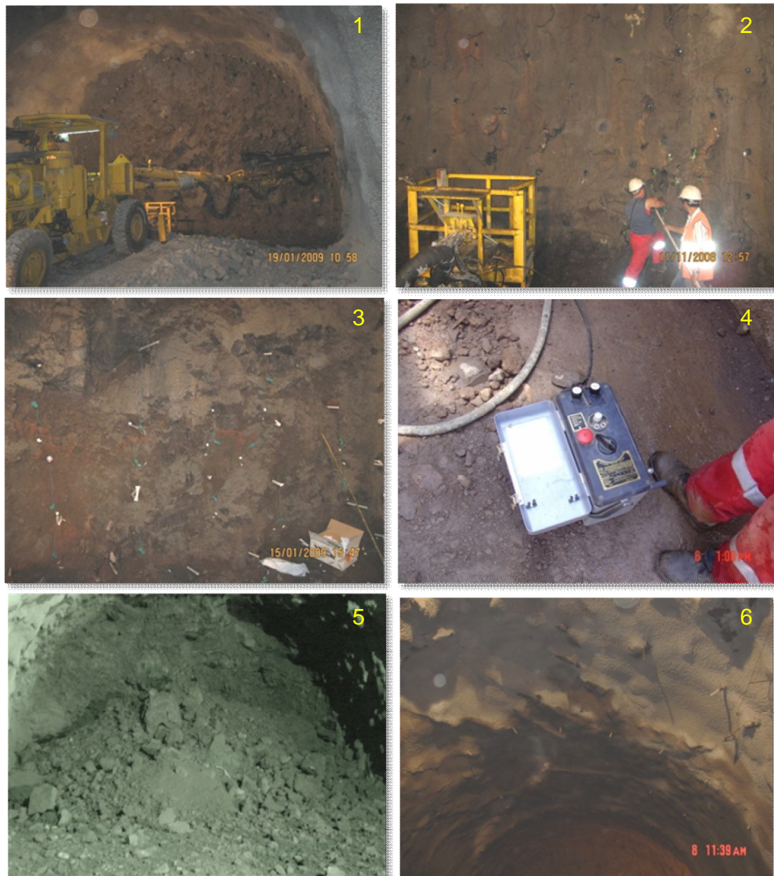
Figura 7.10: Metodologia de avanço com explosivos (1-Perfuração, 2 e 3-Carregamento dos furos, 4-Detonação, 5-Desmonte da frente, 6- Sustimento com pregagens).
