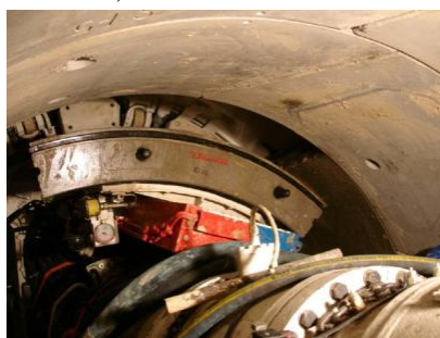
Figura 5.30: Colocação de aduela pré-fabricada (adaptado de CARDONA, 2008).
