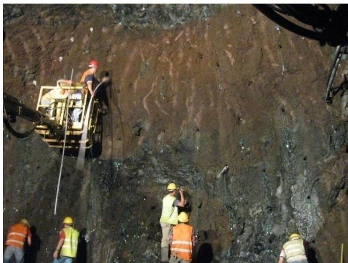
Figura 8.1: Carregamento de uma pega de fogo.
