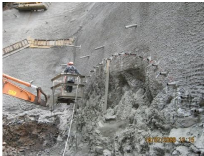
Figura 5.64: Execução do chapéu de enfilagens após contenção do talude.
