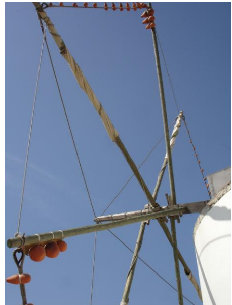
6. Pormenor do mastro oitavado, 4 varas, 4 velas de pano triangulares, presas pelos vértices: um à ponta da vara, outro a um gancho cravado no mastro e outro amarrado com a escota à vara da retaguarda, com disposição helicoidal.
