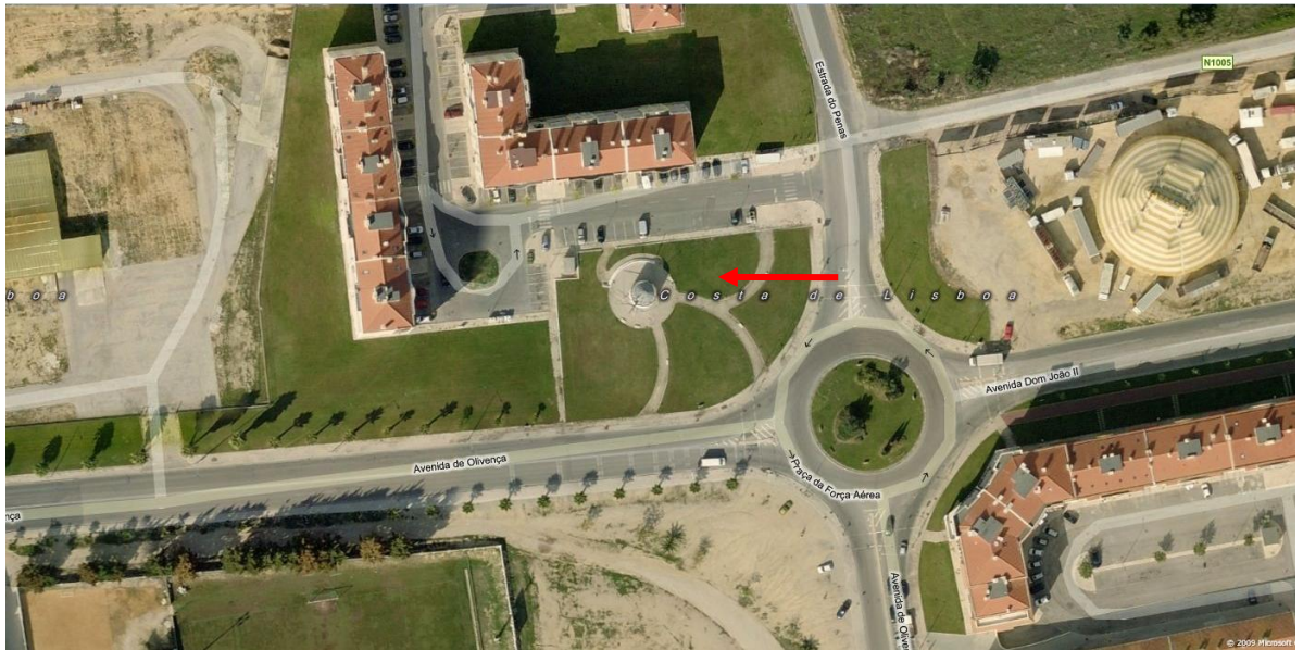
3. Vista aérea do local onde se encontra implantado o Moinho de Vento. 12
