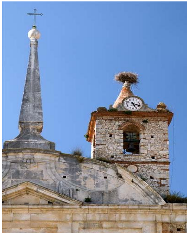
Pormenor da cobertura da igreja do palácio
