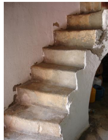
10. Escada adossada à parede de acesso ao sobrado no topo, a escada é assente sobre um arco de berço aberto na parede.
