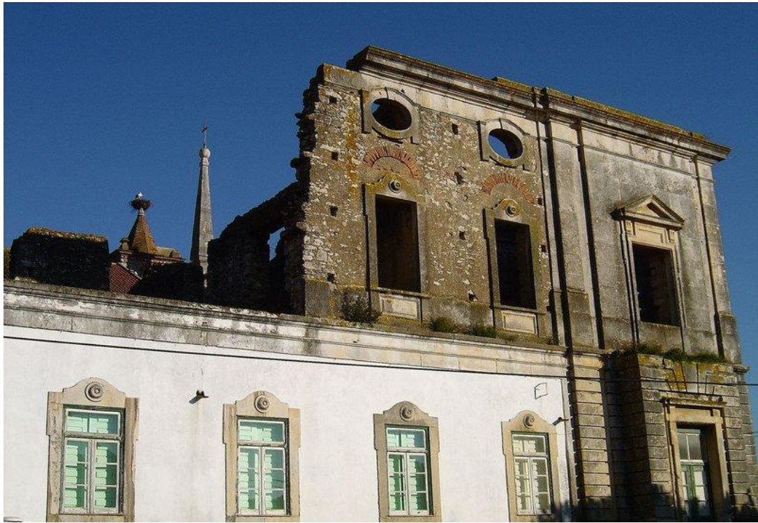
Fachada lateral do palacio
