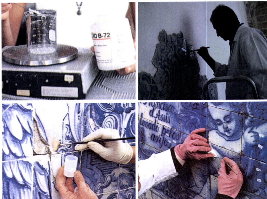
Fig. 5_88 – Preparação de uma emulsão de Paraloid B72 em acetona
