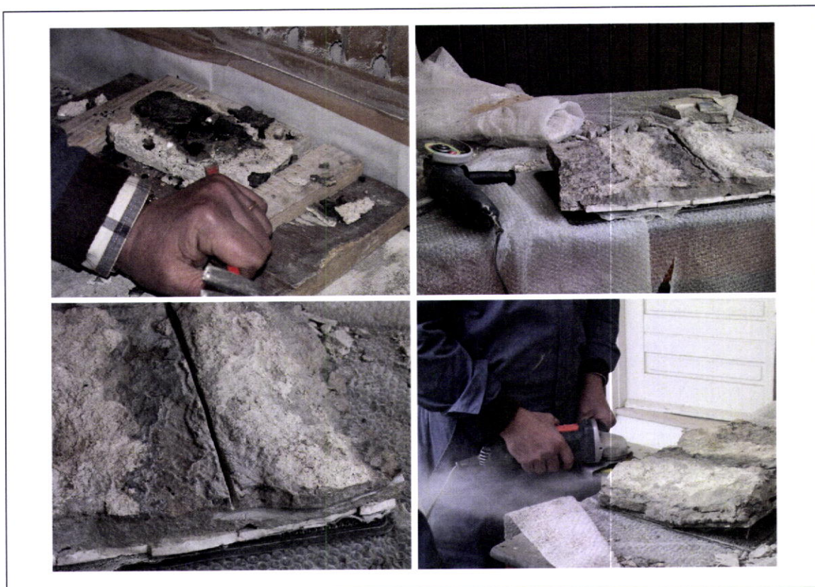
Fig. 5_187 a Fig. 5_190 – Várias fases da limpeza das argamassas nos tradozes dos azulejos. Recurso à um cinzel, e à rebarbadora de disco de corte.
