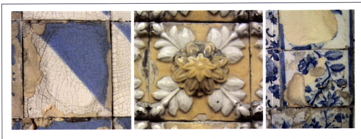
Fig.4_53 – Azulejo “meia-cara” com crateras e fissuração do vidrado (craquelé). Rua Cimo de Vila.
