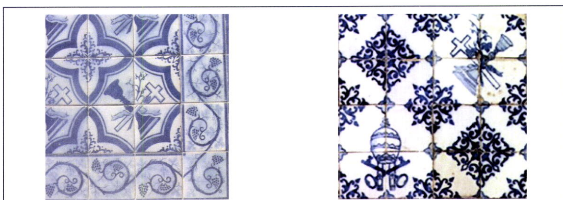
Fig.2_61 – Revestimento da fachada de uma capela existente na Rua D. Manuel II – Capela do Senhor da Boa Morte, onde foi utilizado um azulejo, cujo padrão é composto por quatro módulos diferentes. Fig.2_62 – Revestimento da fachada da Igreja de S. Pedro de Miragaia, onde foi utilizado um azulejo, cujo padrão é composto por nove módulos diferentes.
