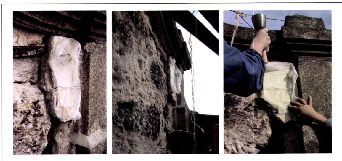
Fig. 5_165, Fig.5_166 e Fig.5_167 – Conjunto de azulejos fortemente agarrados ao suporte. Uso de um maço e cinzel para auxiliar a sua retirada. Estes azulejos encontravam-se colados ao reboco com cimento (provavelmente antigos restauros).
