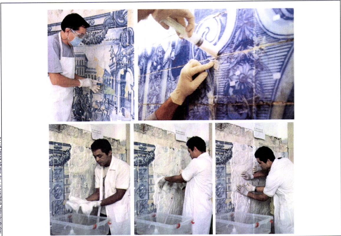
Fig. 5_73 e Fig. 5_74 – Desparasitação de um painel de azulejos, utilizando uma seringa. Fig. 5_75, Fig. 5_76 e Fig. 5_77 – Dessalinização do revestimento em suporte arquitectónico.
