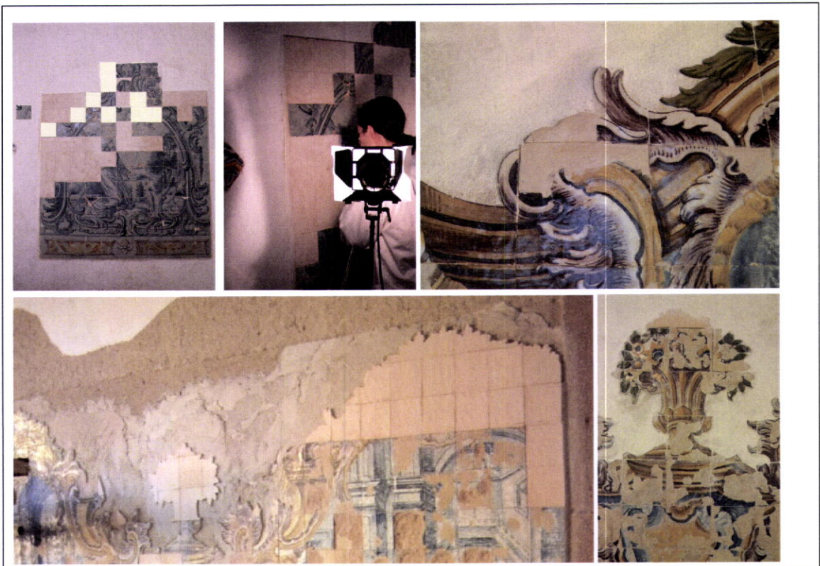
Fig. 5_95 e Fig. 5_96 – Painel no Convento de Cristo em Tomar, onde são visíveis a falta de imagem, resultante de uma intervenção minimalista. Verificação de um novo tipo de intervenção.
