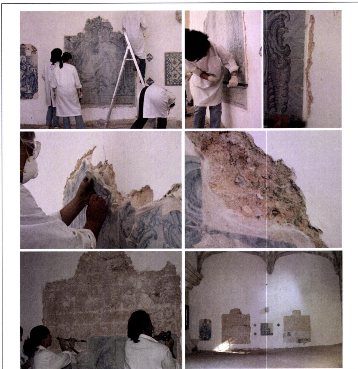
Fig. 5_33 – Após a etiquetagem é feito o facing do painel a ser retirado. Convento de Cristo em Tomar
