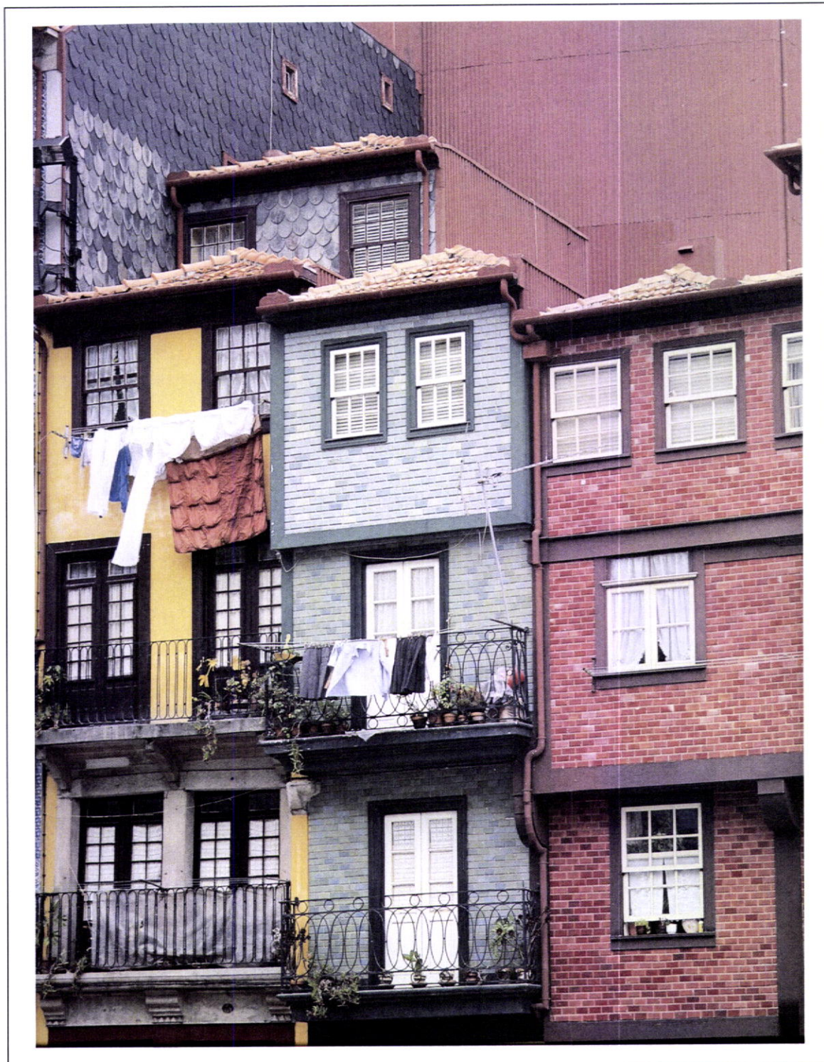
Fig. 3_44 – Conjunto de fachadas azulejadas na Praça da Ribeira, Porto. Edifícios do século XVII, com revestimento das fachadas a azulejo em meados século XIX
