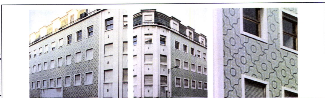
Fig.2_94; Fig.2_95 e Fig.2_96 – Fachada e pormenor do revestimento cerâmico do edifício de gaveto da Rua Vale do Pereiro e Rua do Salitre em Lisboa.
