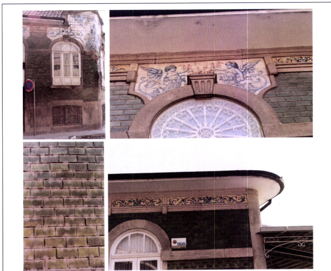
Fig. 5_141 – Vários pormenores da fachada revestida a azulejo e estado de conservação antes da intervenção. Registo fotográfico antes da montagem dos andaimes.
