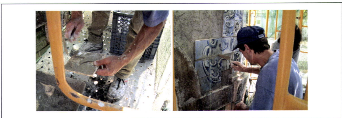
Fig. 5_ 134 –.Recolagem dos azulejos ao seu suporte original, utilizando argamassa de cal
