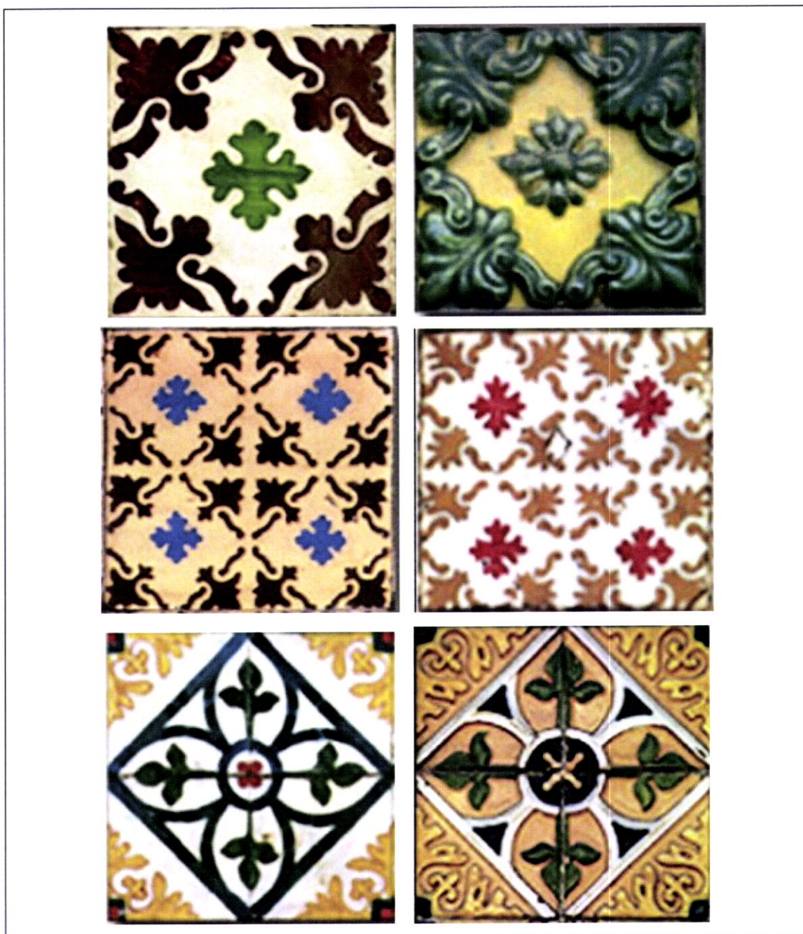
Fig.2_78; Fig.2_79 e Fig.2_80 – Azulejos utilizados nas fachadas do Porto com desenhos semelhantes, utilizando técnicas decorativas diferentes. Na primeira coluna os azulejos são em estampilha Fig.2_81; Fig.2_82 e Fig.2_83 – Azulejos utilizados nas fachadas do Porto com desenhos semelhantes, utilizando técnicas decorativas diferentes. Na segunda coluna os azulejos são em meio-relevo .
