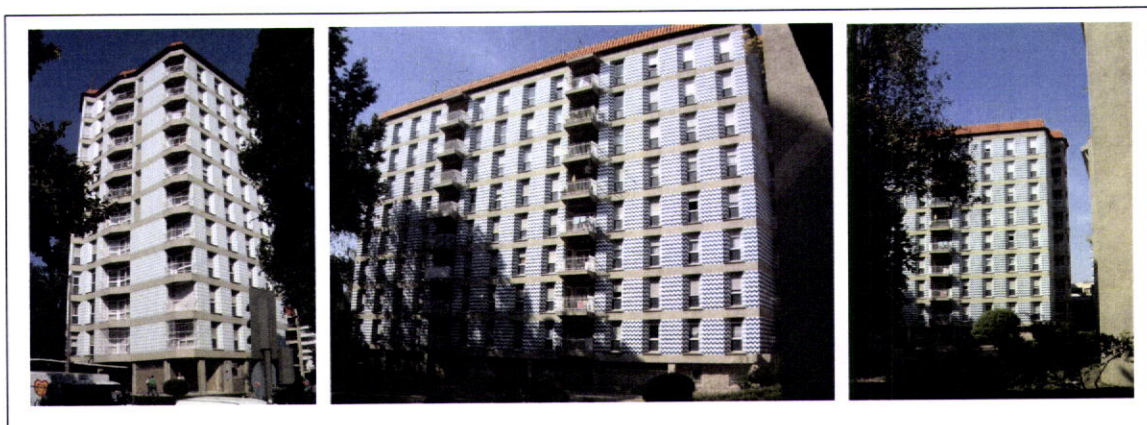
Fig.2_120; Fig.2_121 e Fig.2_122 – Edifícios na Rua da Alegria, no Lima 5. Projecto dos arquitectos Carlos Loureiro e Pádua Ramos 1970. Edifícios de nove e doze pisos revestido com azulejos desenhados pelo arquitecto Carlos Loureiro. Existem três padrões diferentes no complexo, dois dos quais obtidos a partir de módulos já utilizados noutros edifícios dos mesmos autores e um outro novo, obtido a partir de um único módulo.
