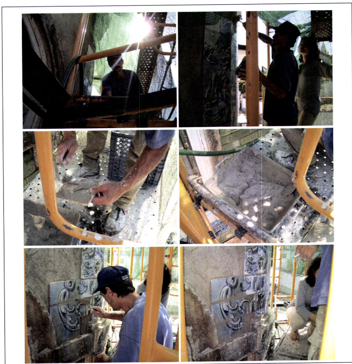
Fig. 5_241 – A parede já se encontra devidamente preparada para receber o azulejo.
