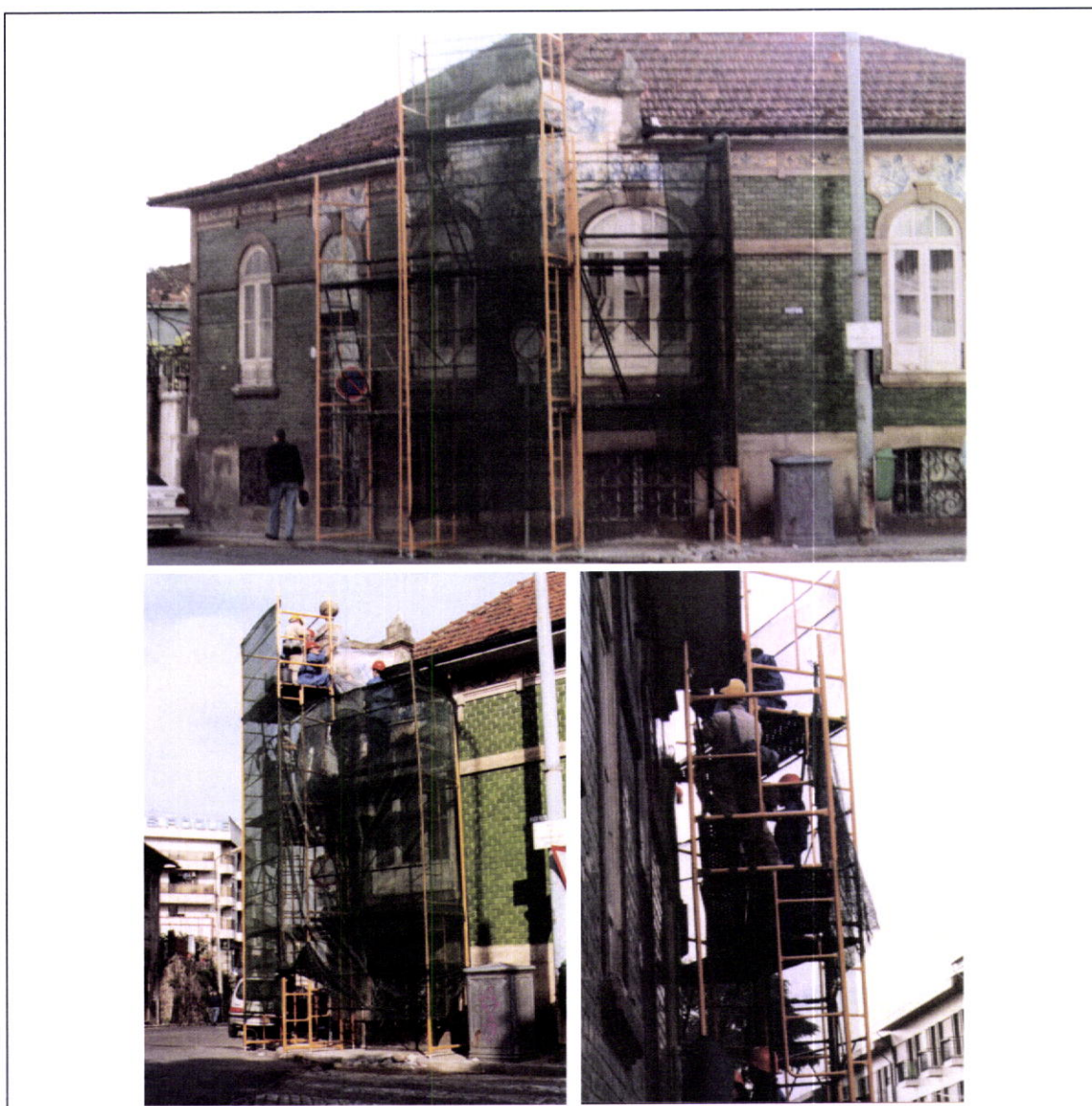
Fig. 5_158 – Várias imagens da montagem dos andaimes e execução dos trabalhos de remoção do painel de azulejos.
