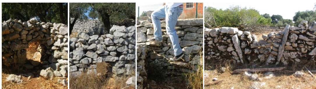
Figuras 144, 145, 146 e 147 | Particularidades dos muros de pedra seca
