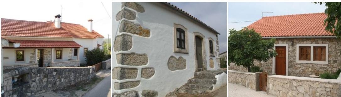
Figuras 103, 104 e 105 | Habitações recuperadas, Alvados, Alcaria e Vale de Ventos, respectivamente
