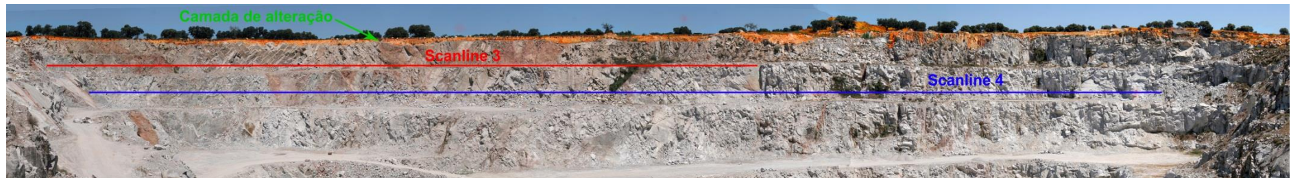
Fig. 11 - Fotografia da frente de desmonte onde foram efetuadas as scanlines 3 e 4, com a orientação NE-SW. Pode ser observada nesta fotografia a camada superficial de alteração, obtida através da observação visual no terreno e posterior tratamento de imagem.
