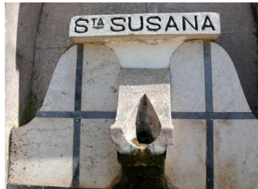
Fotografia 34 – Detalhe da Fonte de Santa Susana, na entrada de Aljezur, EN 120, 20.04.2012.
