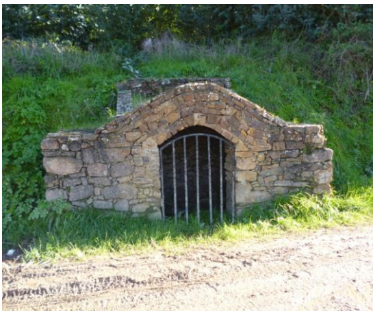
Fotografia 35 – Fonte das Mentiras, Vila de Aljezur, 27.05.2012.
