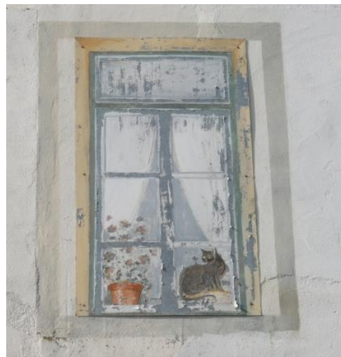
Fotografia 26 – Detalhe de uma parede de um edifício abandonado, na zona histórica, Vila de Aljezur, 03.03.2012. Autoria: Mónica Viegas
