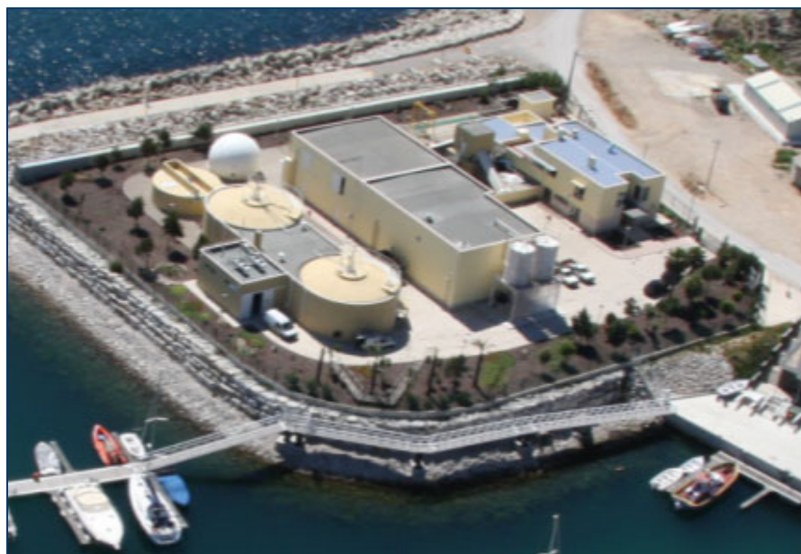
Figura 26 - Vista da ETAR de Sesimbra.
