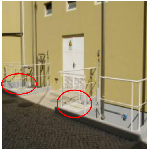
Figura 31 - Poço de condensados
