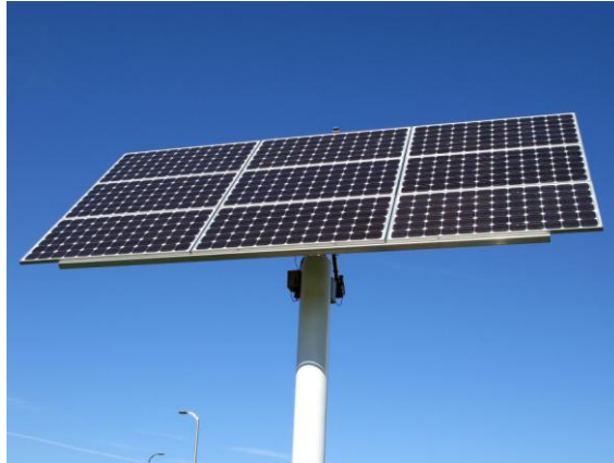
Figura 16 – Painéis Fotovoltaicos – Sistema com seguidor solar
