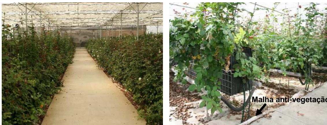
Figura 13 – Revestimento do piso e espaços de circulação interior da estufa
