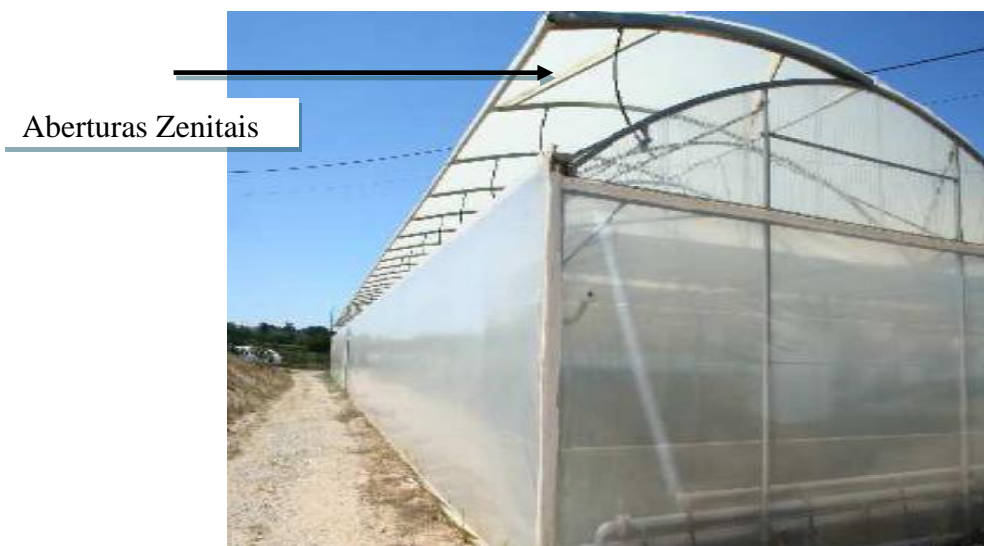
Figura 11 – Revestimento da estufa
