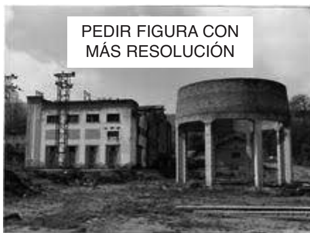
Figura 6. A central Lena já desactivada (anos sessenta). À direita a nova torre de arrefecimento, em alvenaria e tijolo, construída nos anos quarenta.
