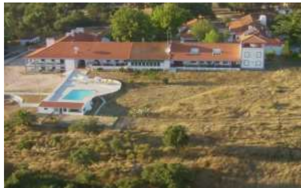
Fig. 8 - Estas três fotografias pretendem realçar os diferentes níveis, maiores ou menores de afectação, da adaptação dos montes a unidades turísticas. Em cima, nos casos da Quinta de Montemuro (Foto: J.M. de Mascarenhas, 2014) e da Quinta do Vale do Poço (Foto: J.M. de Mascarenhas, 2009), os impactos são ligeiros. Tal já não acontece no exemplo de baixo (Monte dos Arneiros) em que se percebem grandes adulterações na forma e volume da primitiva estrutura (Foto: J. Policarpo, 2003).
