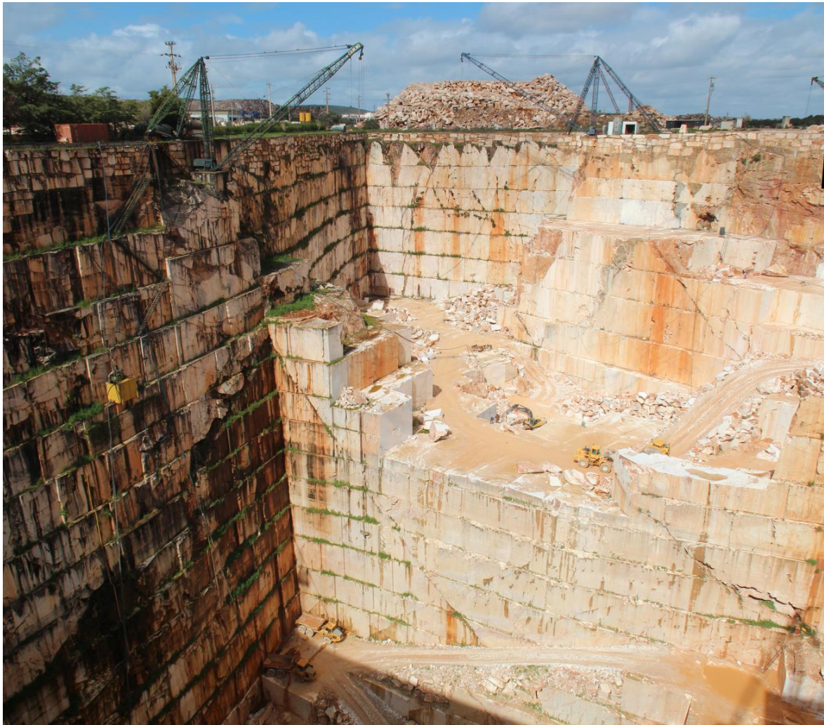
Figura 1 – Cavidade atualmente em exploração por duas empresas que em setembro de 2013 se encontra com oitenta e cinco metros de profundidade. Repare-se como no espaço onde se desenvolve regularmente a atividade extrativa não é possível a fixação de qualquer planta, no entanto nos patamares, ainda que de reduzidas dimensões, dos pisos já explorados é possível ver um coberto vegetal incipiente. Registe-se que no inverno de 2012/2013 a pedra mais profunda esteve com laboração suspensa e o nível freático subiu até quase atingir o patamar correspondente à pedra mais profunda. Nas pedreiras ativas são usuais e frequentes os bandos de Pombo-das-rochas ( Columba livia ) que aí encontram condições ótimas para nidificarem. Fotografia de Luís Lopes.
