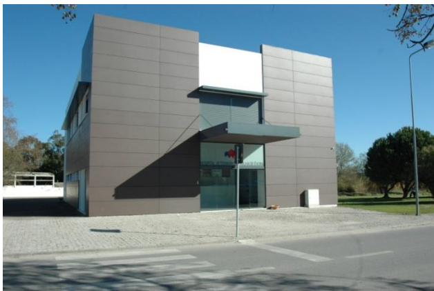
Imagem 3. Hospital Veterinário Muralha de Évora (HVME, 2010)
