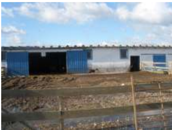
Imagem 25 - Parques exteriores da exploração da Igrejinha (original do autor).
